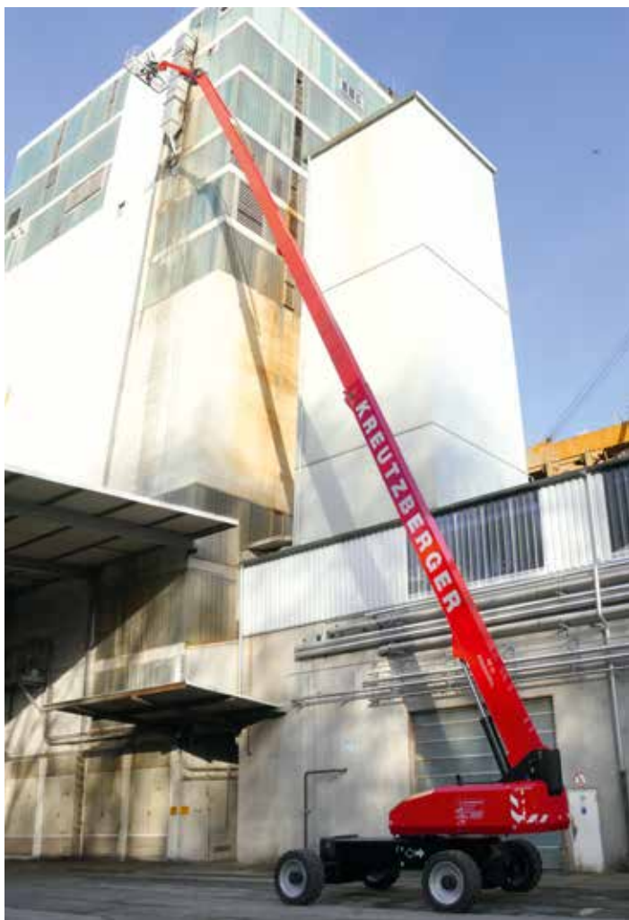
Die JLG Teleskopbühne 1500SJ macht Arbeiten in über 47 m Höhe möglich. Der sehr bewegliche Korbarm lässt, wie hier in Kiel, auch schwierig erreichbare Arbeitsorte ansteuern.
