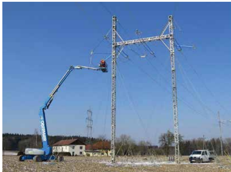
Für die Revision von Hochspannungsleitungen am Umspannwerk Hausruck in Oberösterreich wurde eine Gelenk-Teleskopbühne vom System Lift-Partner Obermair eingesetzt. (Fotonachweis: Obermair/AVS System Lift AC)
