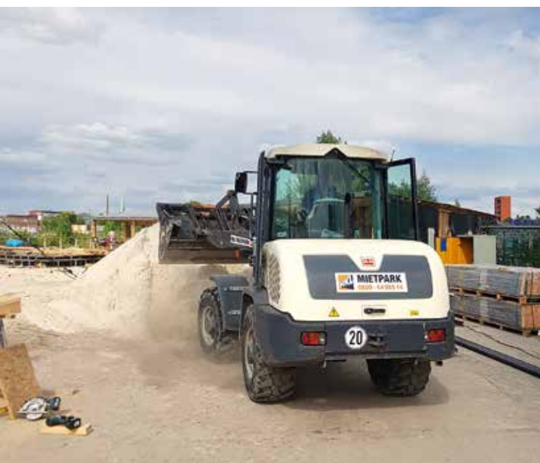
Ein Radlader aus dem HKL Mietpark übernahm das Verteilen von 400 Tonnen Sand für den Party-Strand, der bis zu 2.000 Leute fasst.
