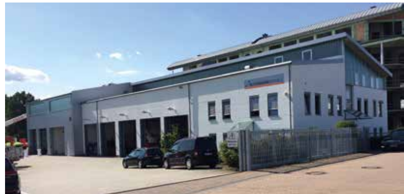
Der hintere, neue Gebäudeteil erweitert die Kapazitäten der Servicestation in Groß-Gerau um 40 %.
