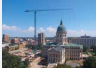
Ein Comansa 21 LC 400 in Topeka im Einsatz.
