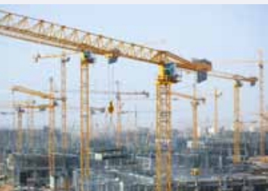
Auslegerwald in Riad beim Bau der neuen Frauen-Universität
