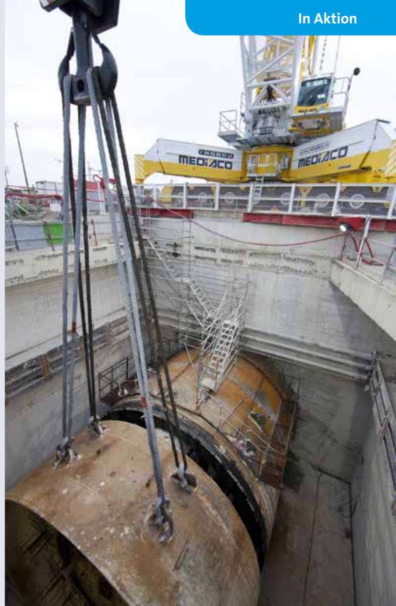
Das Antriebssegment für den Bohrschild der Tunnelbohrmaschine hat einen Durchmesser von 7,9 m und wurde vom LG 1750 aus 15 m Tiefe emporgehoben.
