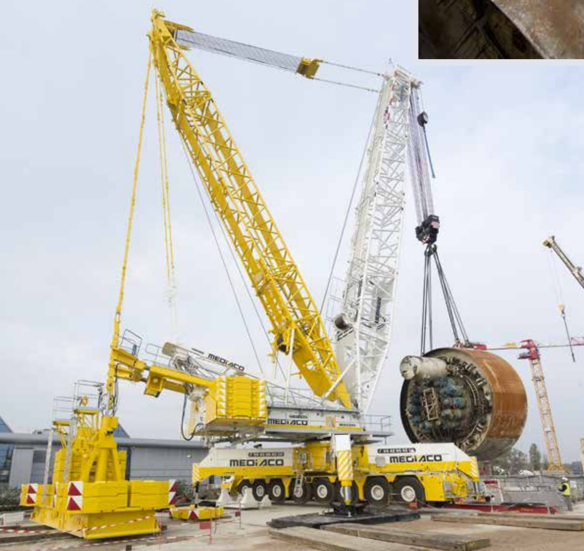
Das Antriebssegment für den Bohrschild der Tunnelbohrmaschine hat einen Durchmesser von 7,9 m und wurde vom LG 1750 aus 15 m Tiefe emporgehoben.
