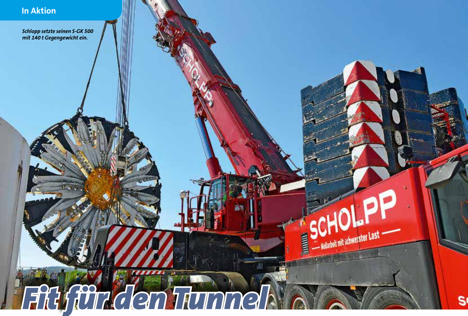
Runde Sache: einer der Bohrköpfe mit 10,52 m Durchmesser „schwebt“ an seinen Bestimmungsort.
