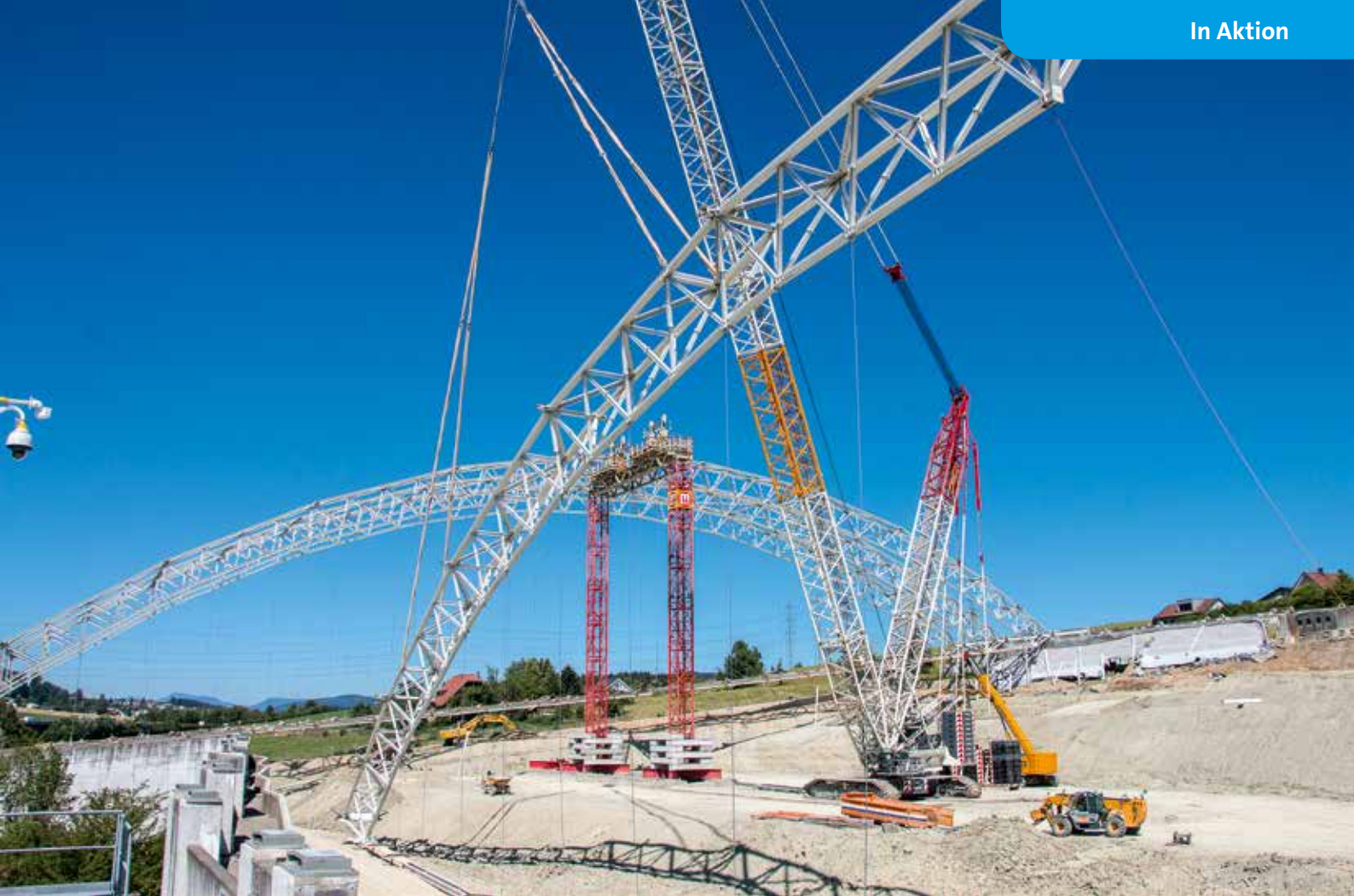
Vor dem Absetzen muss Superliftballast abgebaut werden.
