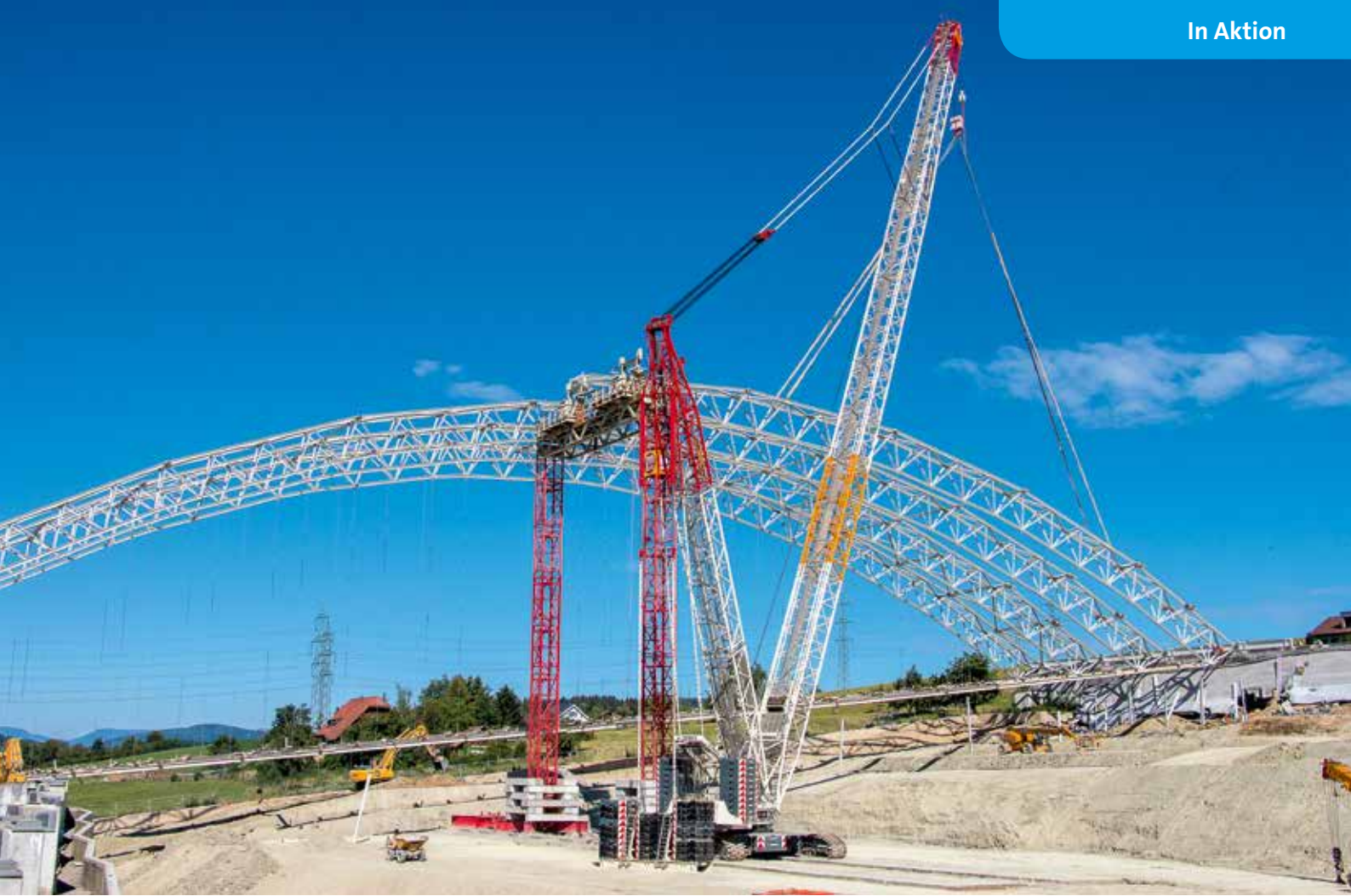
Etwa einen Monat später, noch sieben Hübe stehen an.
