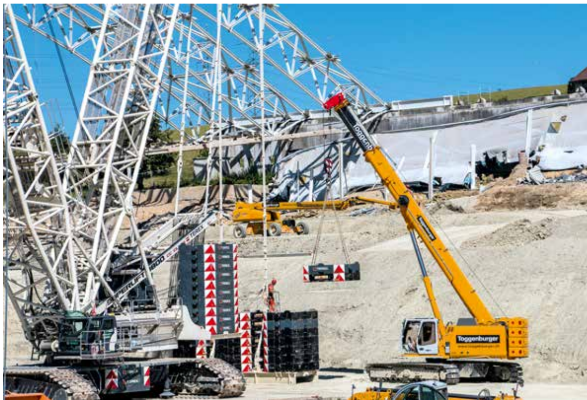
Um den Superliftballast um 125 t zu reduzieren, ist ein Sennebogen-Teleskop-Raupenkran im Einsatz.
