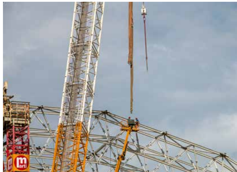
Das Einhängen der Hebegurte erfolgt mittels einer Arbeitsbühne.
