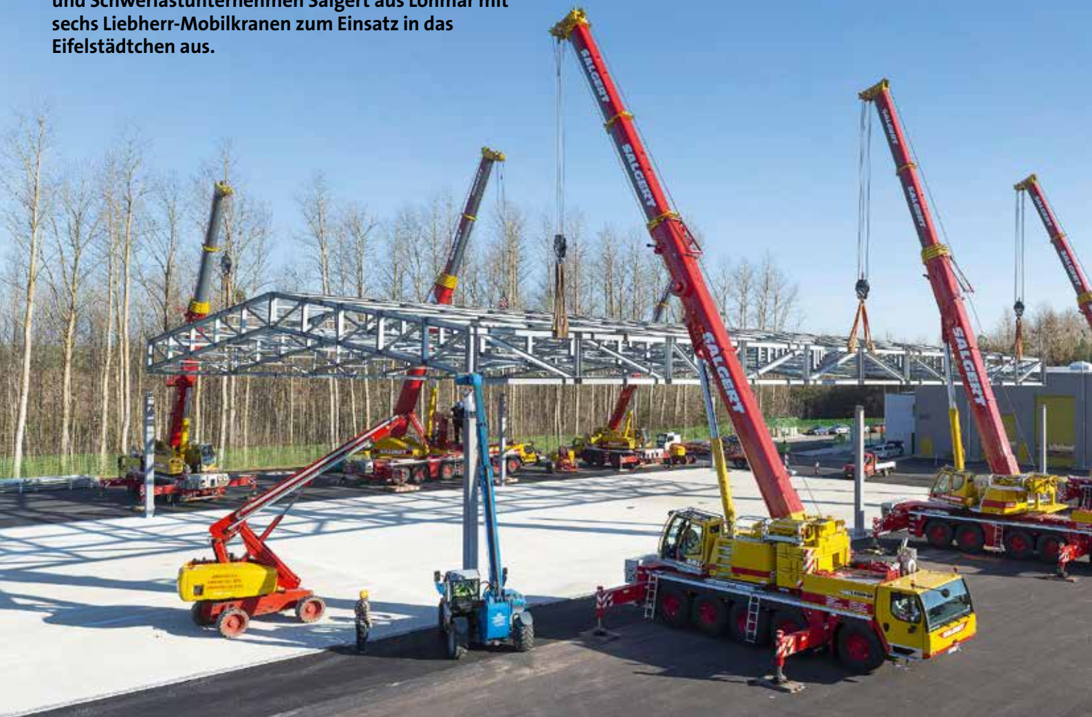
Am Haken: Die große Dachkonstruktion hängt an den Kranhaken. Mithilfe eines Teleskop-Laders werden die Pfeilerverlängerungen eingebaut.
