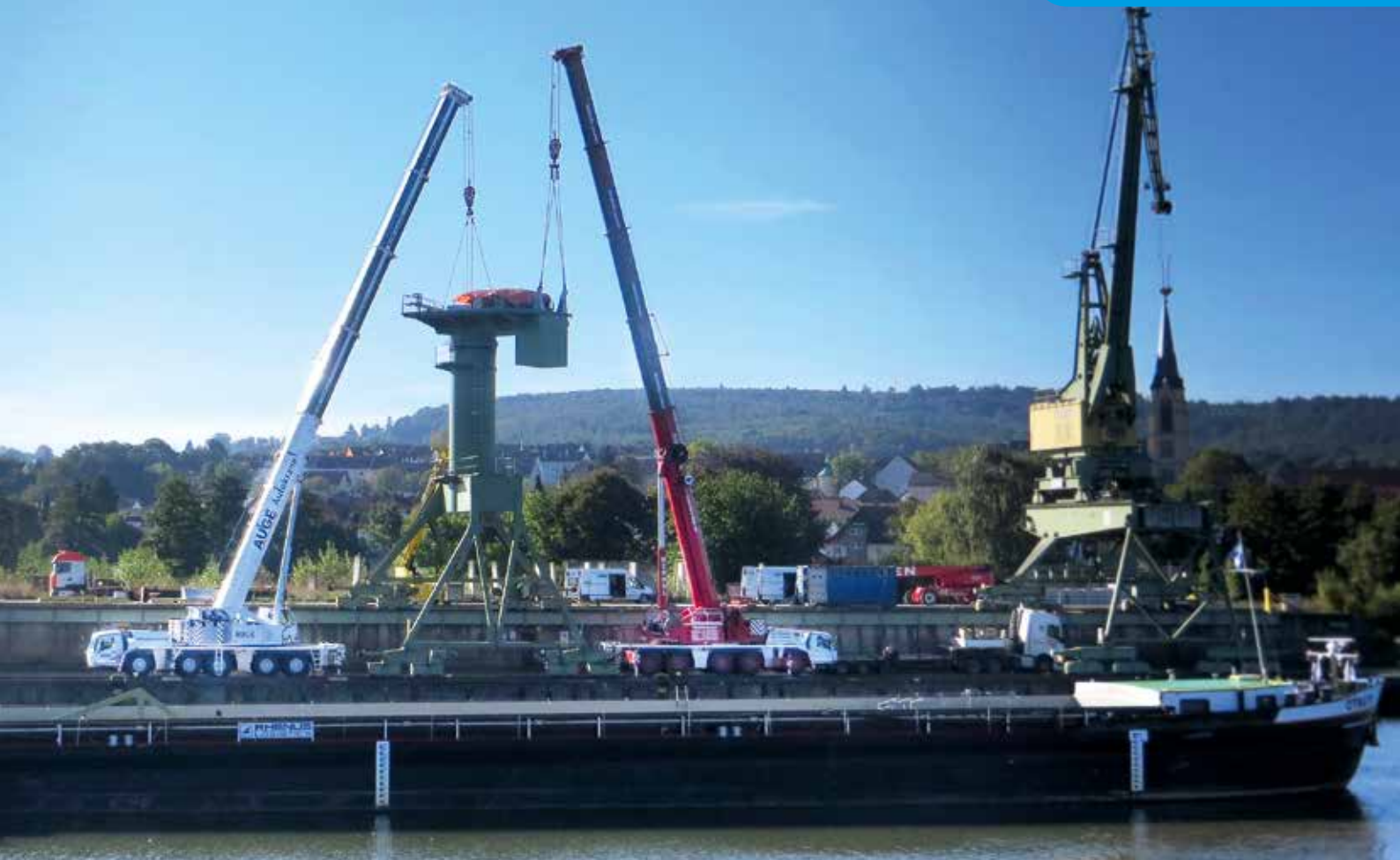
Auf der Ebene zwischen Kaimauer und Main-Donau-Kanal wurden die Krane für den Hub in Position gebracht.
