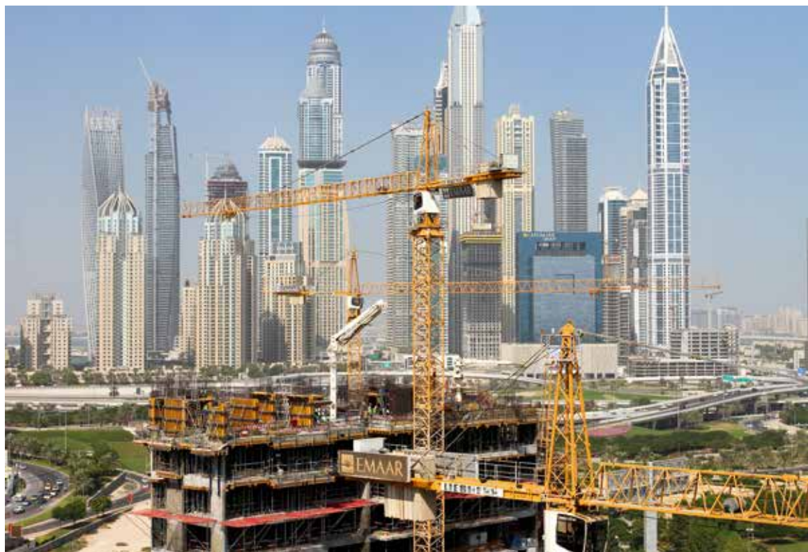
Sieben Turmdrehkrane des Typs 200 EC-H beim Bau von „The Hills“, einem Projekt mit vier Türmen in Dubai.
