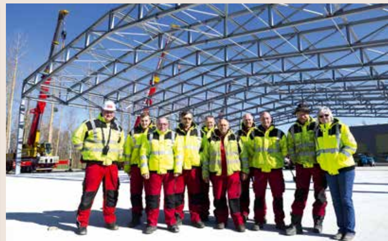
Geschafft: Einsatzleiter Gerd Müller (links) und sein Team sind nach dem erfolgreich durchgeführten Auftrag sichtlich zufrieden.
