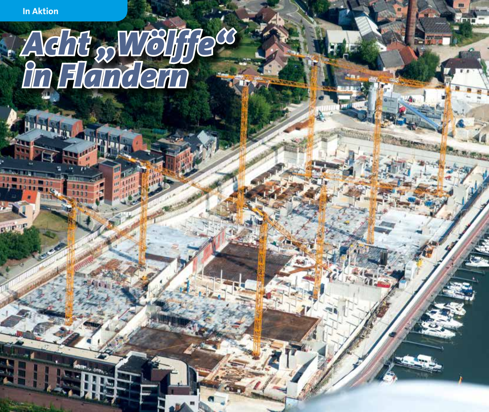
Im Auftrag von STRABAG Belgium NV bauen acht Wolff-Krane das moderne Stadtviertel „Quartier Bleu“ am Yachthafen von Hasselt.
