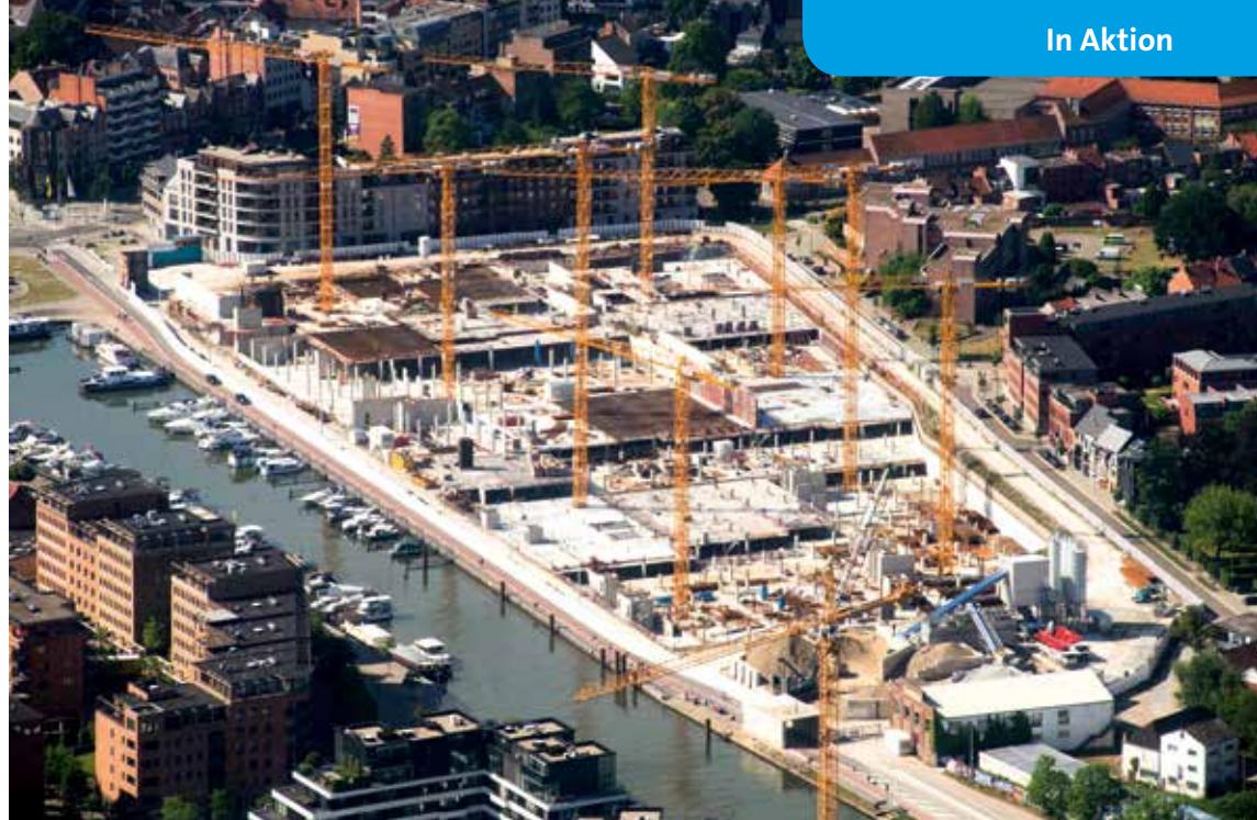
Alle eingesetzten Krane sind spitzenlose Obendreher der Typen Wolff 6015.8 clear, 6023.8 clear, 6031.12 clear und 6031.8 clear.
