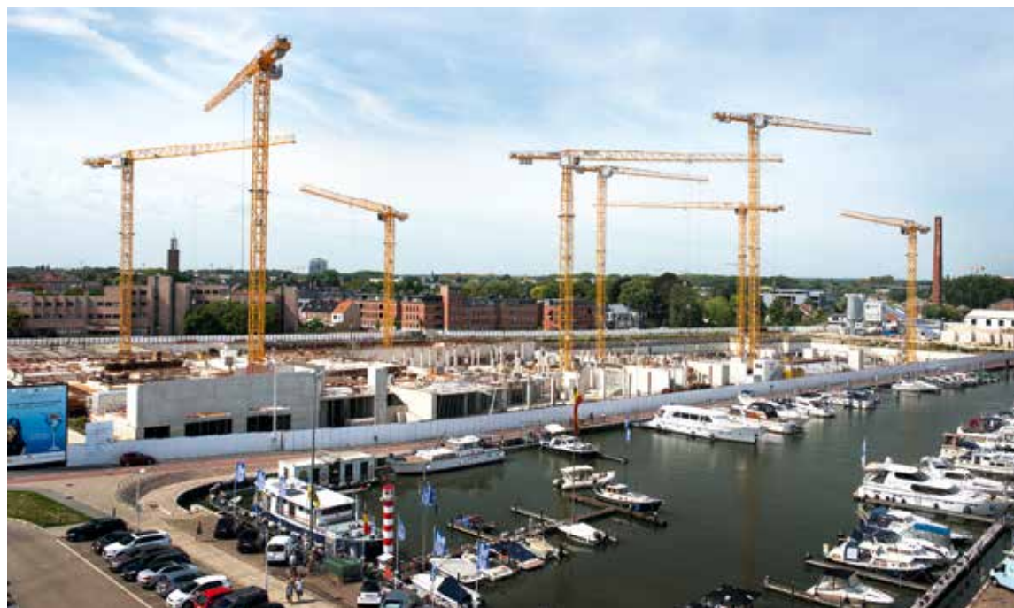
Dank exakt abgestimmter Hakenhöhen und Ausladungen können die Krane problemlos untereinander durchschwenken, ohne sich beim Materialtransport auf der beengten Baustelle zu behindern.
