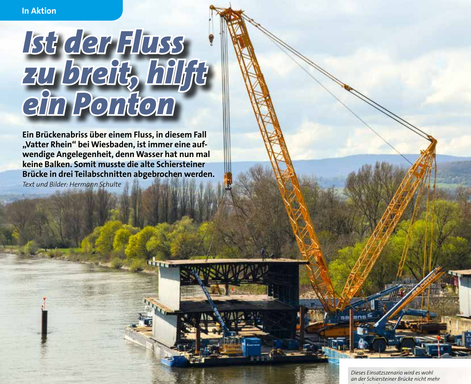
Umschlag der Brückenteile auf den Verschrottungsplatz.
