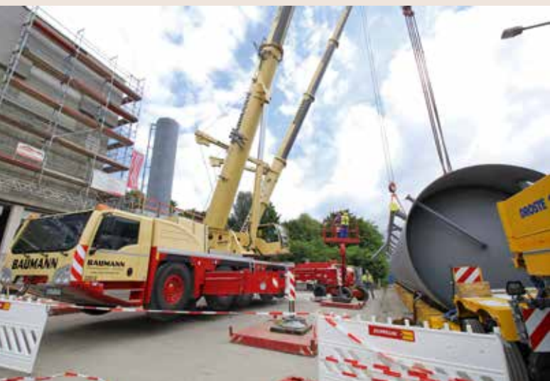
Ein Terex Explorer 5800 unterstützt beim Aufrichten.
