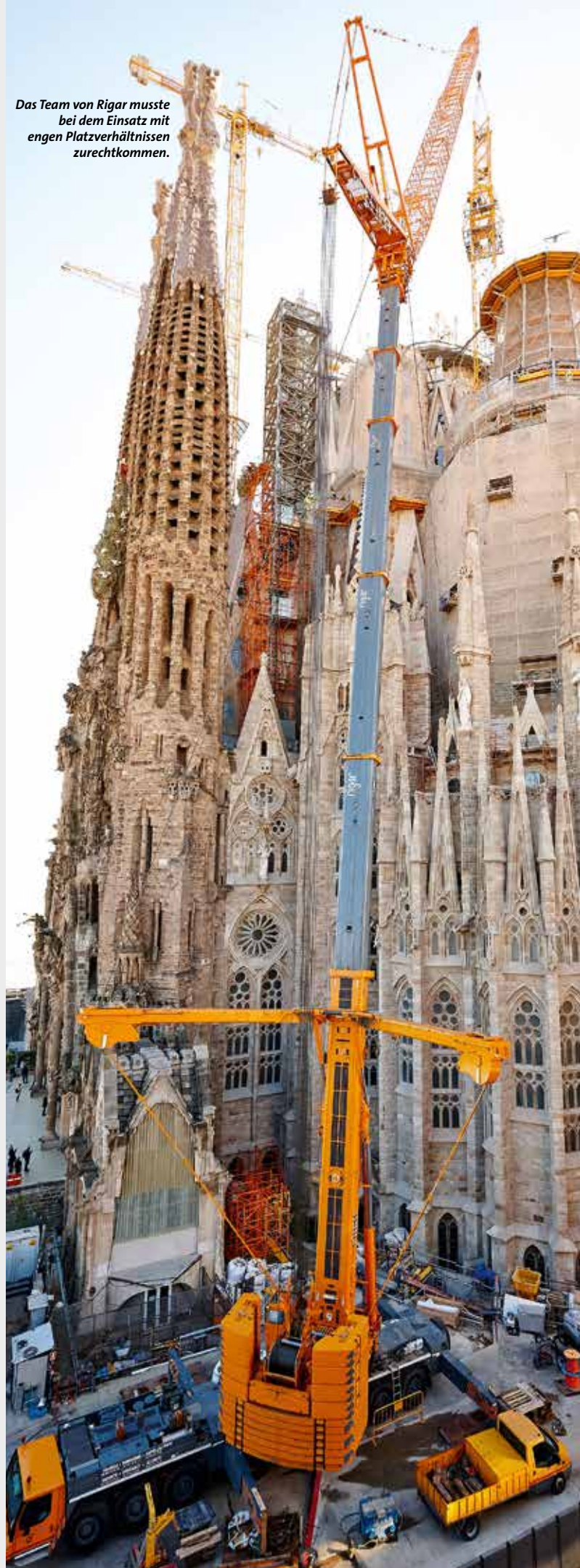
Der LTM 1500-8.1 wurde für diesen Einsatz mit dem maximalen Gegengewicht von 165 t ballastiert.
