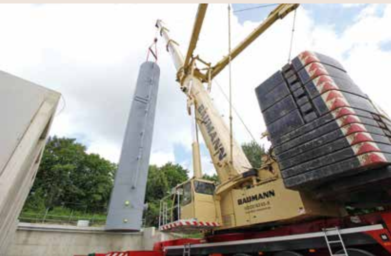
Nur mit 165 t Ballast und Mastabspannung erreicht der 500-Tonner die erforderliche Ausladung von 21 m.
