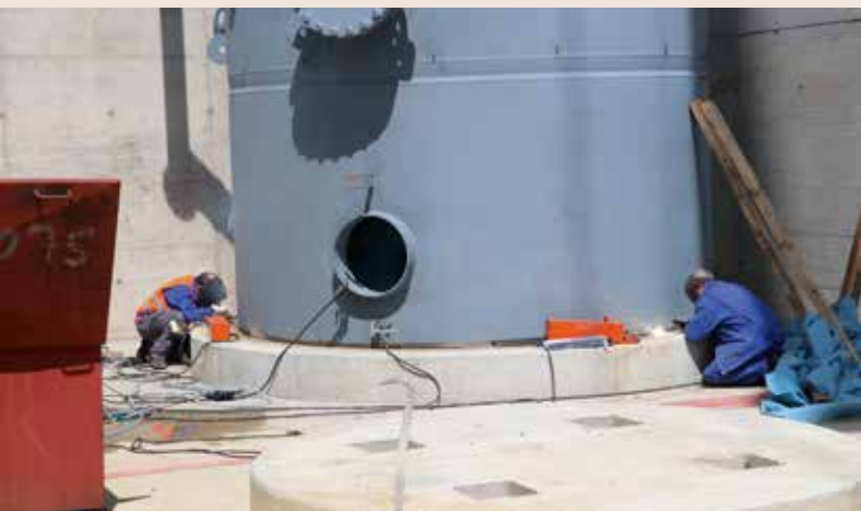
Millimetergenau ausgerichtet wird der Wärmespeicher schließlich an das Fundament geschweißt.
