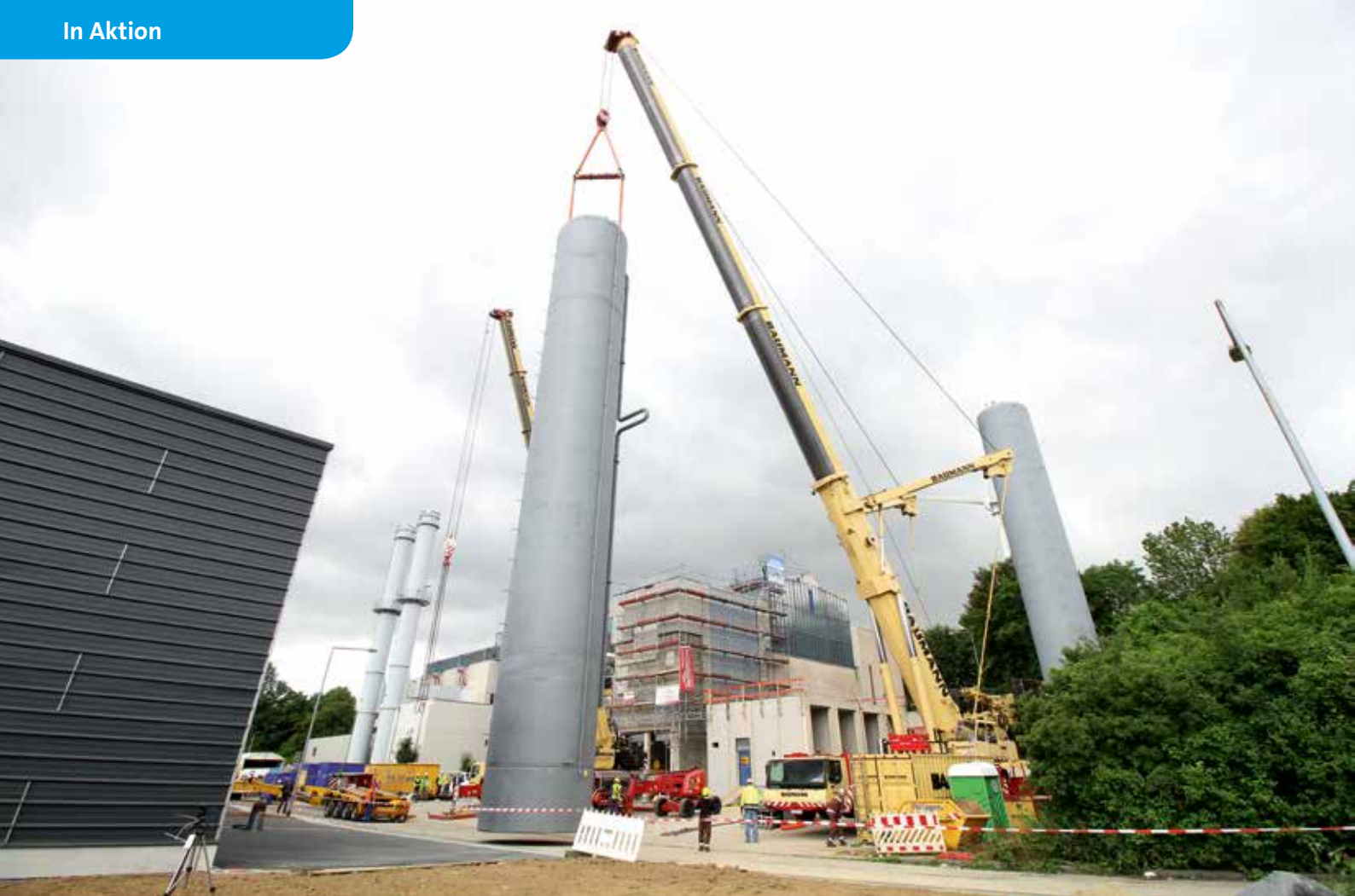
Eine Woche später kam der zweite Speicher an den Haken.
