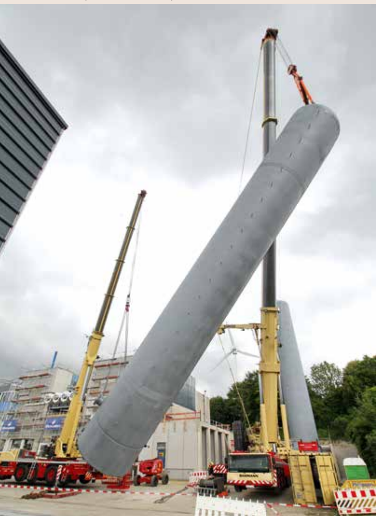
Mit dem 200-Tonner als Nachführkran wird der Behälter in die Senkrechte gedreht.
