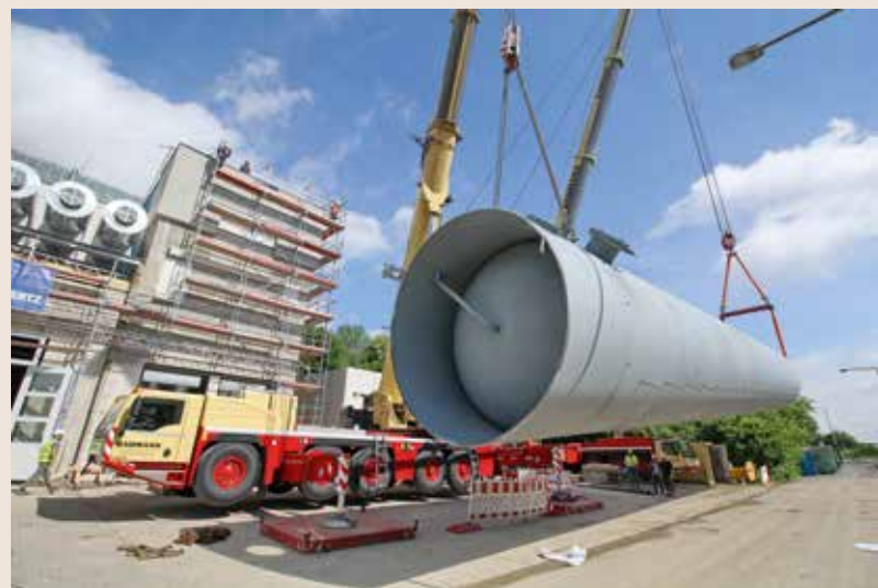
Der 65 t schwere Behälter hängt frei über der Straße.
