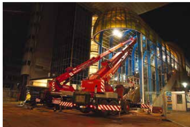
Für das Einheben einer Fußgängerbrücke erhielt Wagenborg den ESTA-Award in der Kategorie „Kranarbeiten bis 120 t“.
