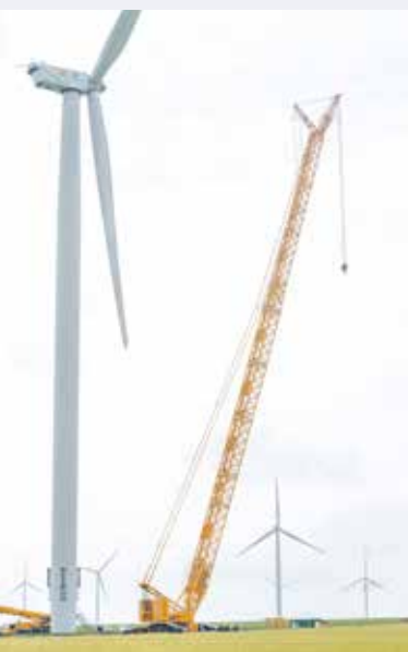
CEZ setzt den LR 1600/2 und den LTM 1130-5.1 hauptsächlich für Wartungsarbeiten an Windkraftanlagen ein.
