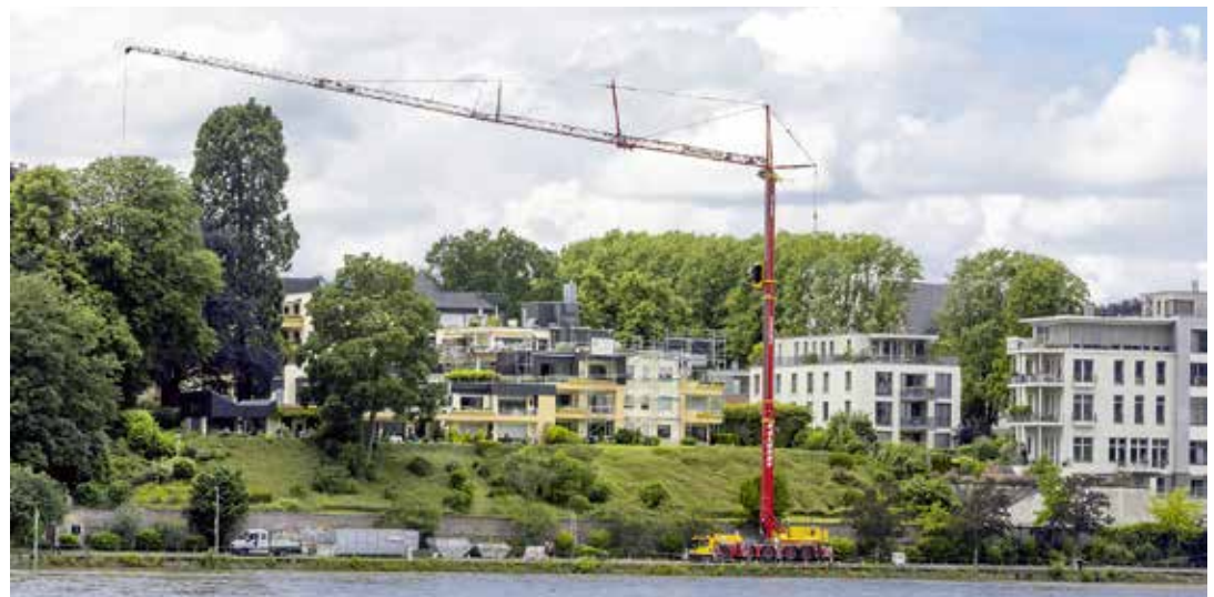
Einsatz am Rheinufer in Bonn: Liebherr MK 140 Plus der Salgert GmbH.
