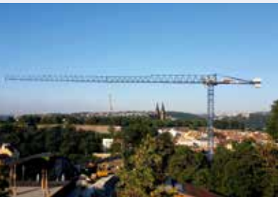
Comansa 11LC160 im Einsatz.
