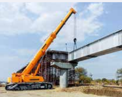
Der neue LTR 1220 von NCC Ltd. hebt Träger für das U-Bahn Projekt in Nagpur.
