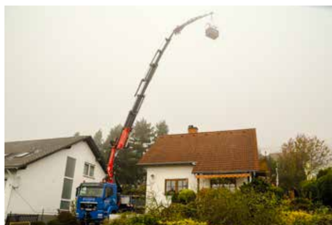
Der zur Verfügung stehende Standplatz in der Einfahrt war wie geschaffen für den 4-Achser, denn durch die Zusatzausrüstung mit einem Überwachungssystem zur Aufnahme von Zusatzballast auf der Ladefläche und Neigungssensoren konnten 360 Grad Arbeitsbereich erreicht werden.
