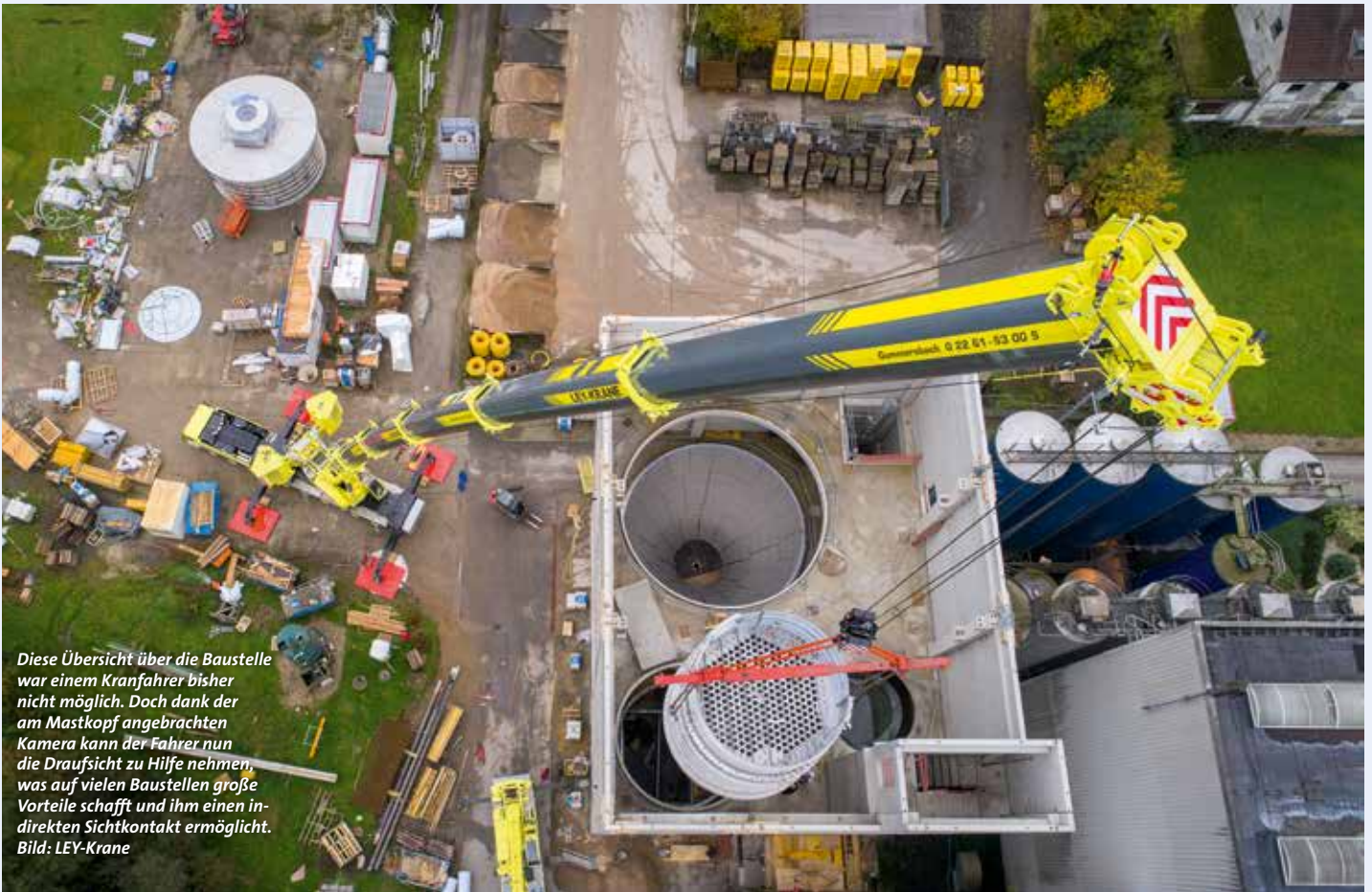
Unterschiedliche Ausschubvarianten sorgen für die optimale erforderliche Tragkraft. Wie geschoben werden muss, gibt die intelligente LICCON-Steuerung an. So sind sogar 26,5 t auf 30 m möglich. Bild: Andreas Cichowski
