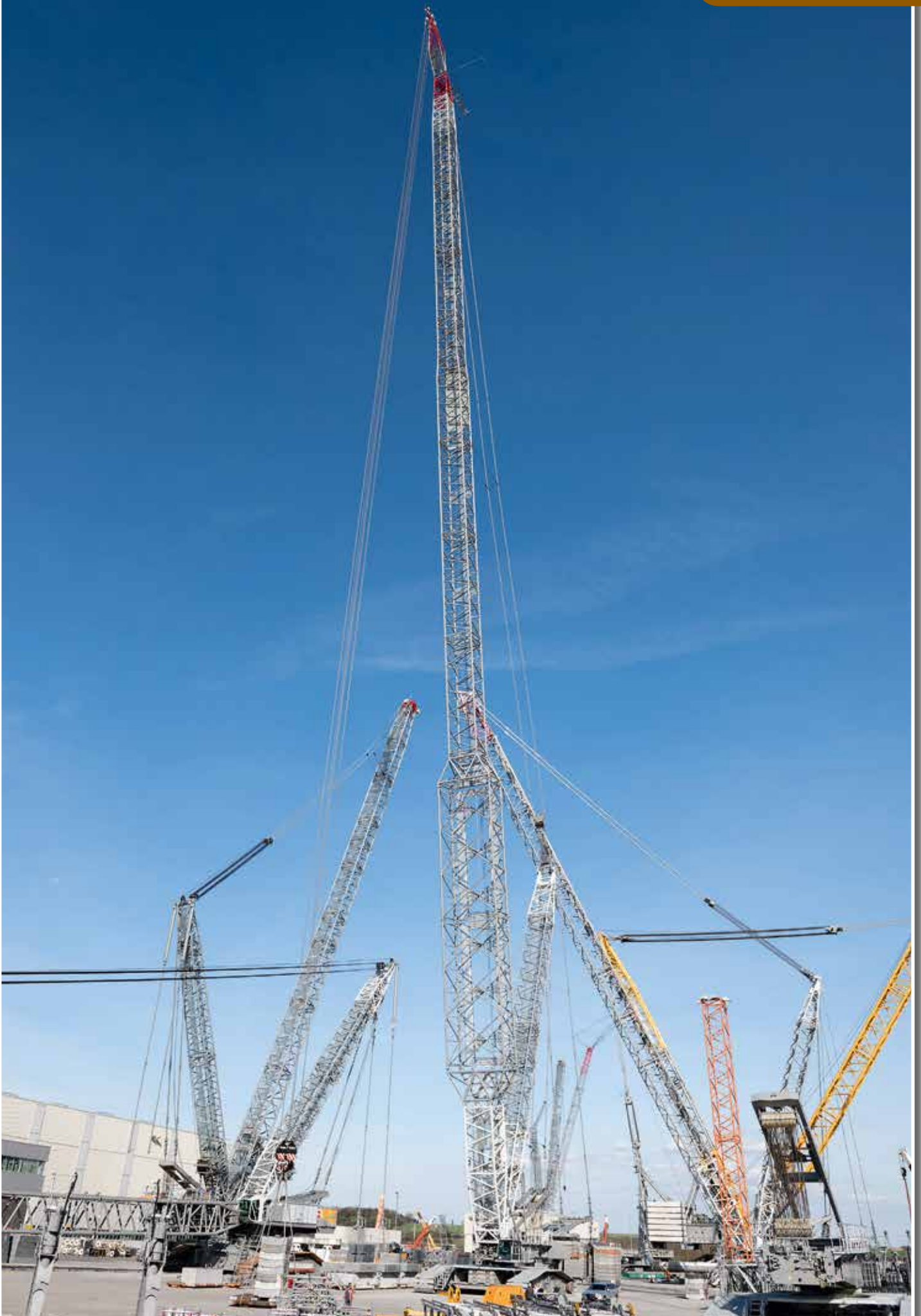
Das SX2-Auslegersystem wird auf dem Liebherr-Abnahmegelände getestet.
