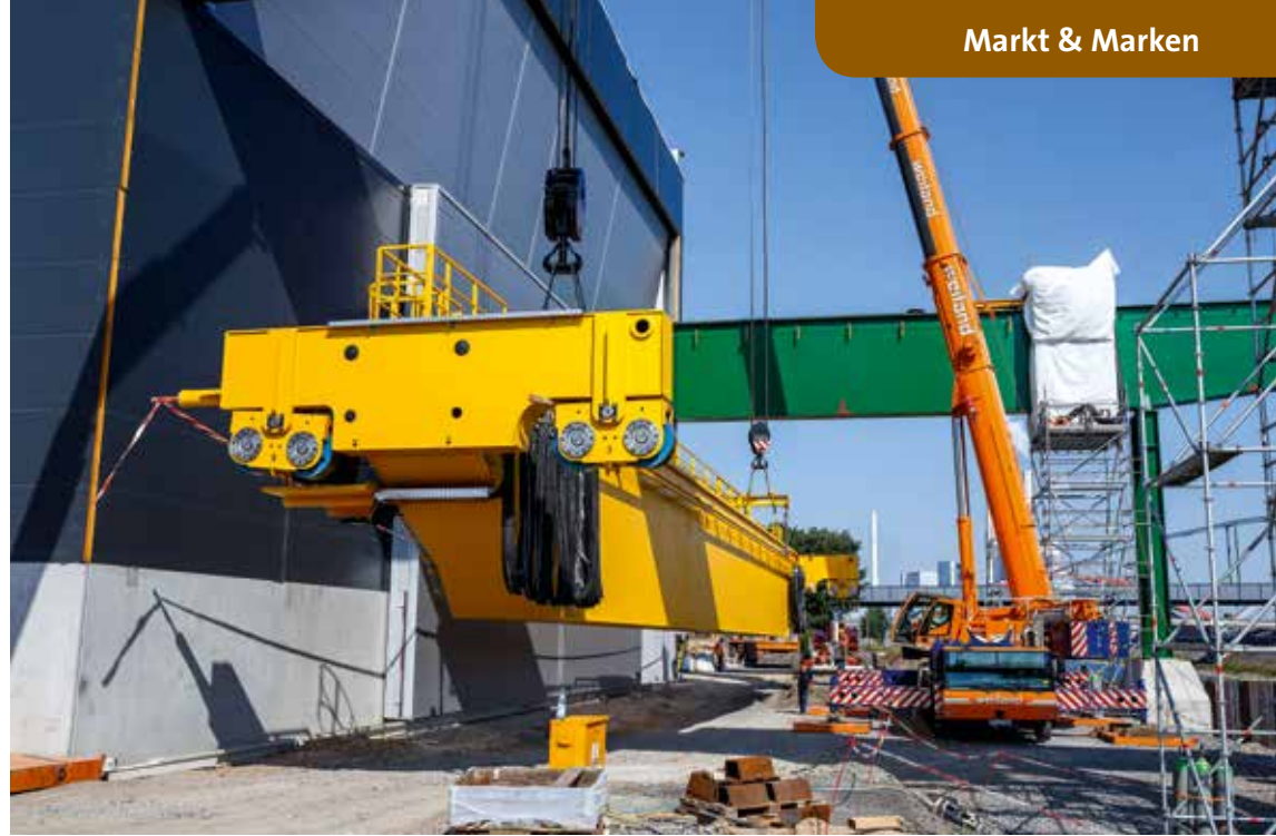
Insgesamt 500 t Tragkraft bietet dieser Zweiträgerbrückenkrane von Brunnhuber.
