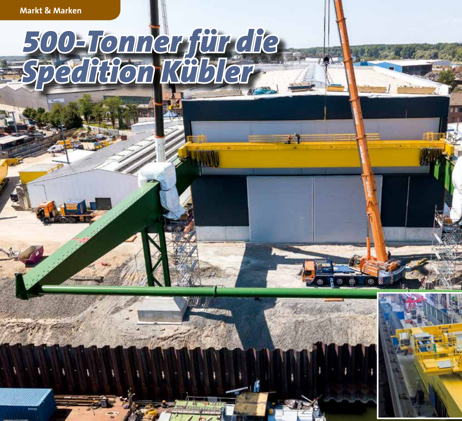
In Mannheim wird der Brunnhuber-Kran Schiffsmotoren umschlagen.
