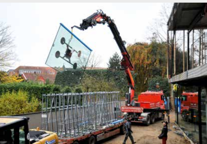
Entnahme der 500 kg Glasscheibe mit Vakuumsaugbatterie vom Bock.
