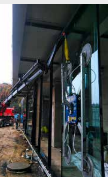
28 m Ausladung inklusive Schwanenhalskonstruktion ermöglichen eine präzise Platzierung.
