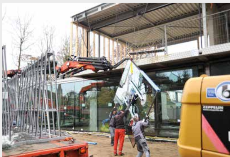
Die Glasscheibe kann am Sauger manuell gedreht und in Position gebracht werden.
