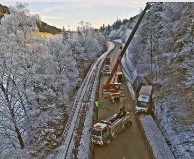
Ein Mobilkran und ein AWU waren bei der Bergung im Einsatz.
