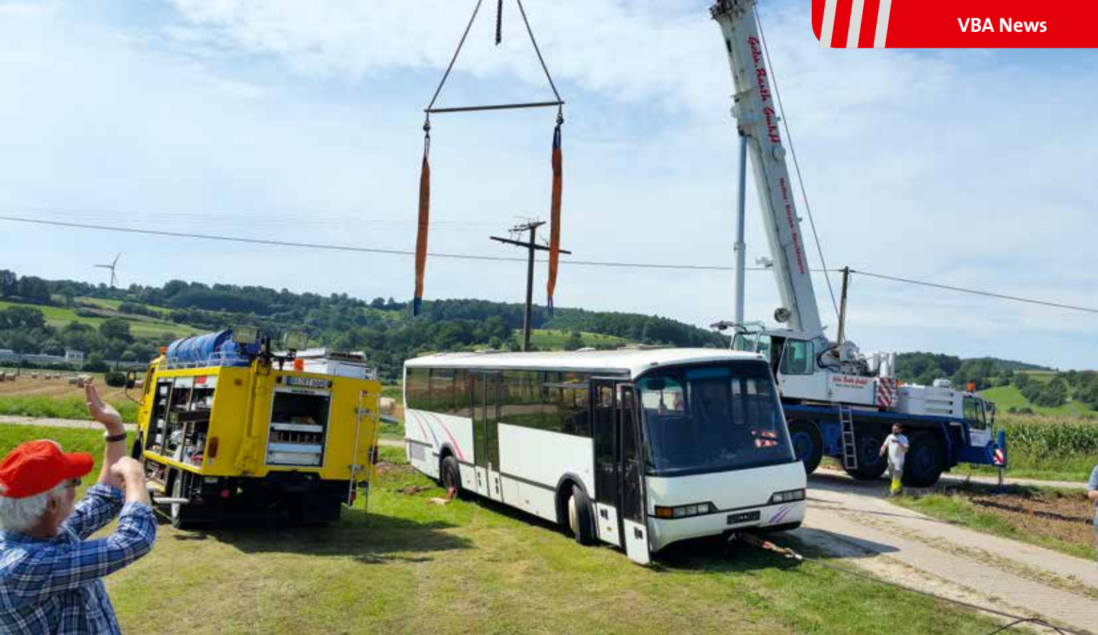
Nachdem die Seminarteilnehmer zunächst ein Abrollkipper aus einer Sandgrube geborgen hatten, stand in der zweiten Übung ein Bus in Schräglage im Graben und sollte zurück auf die Straße gebracht werden. Hier kam Hebegeschirr und ein Mobilkran zum Einsatz.
