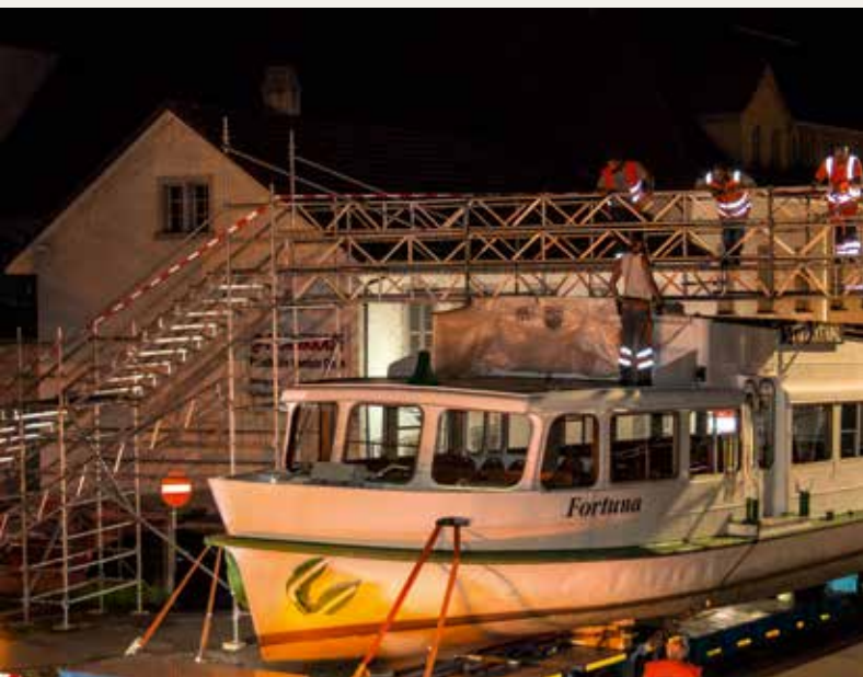
Diese Passerelle wurde zu niedrig aufgebaut.
