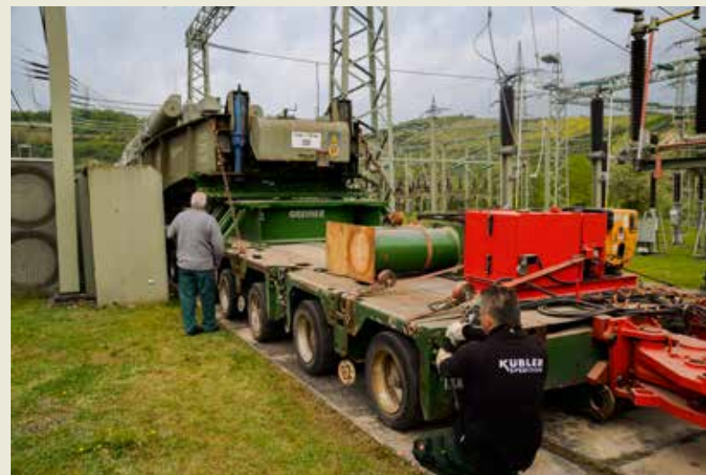
Angesichts der kurzen Fahrstrecke nahmen die Verladung und das Umsetzen des Trafos der zeitlichen Löwenanteil in Anspruch.
