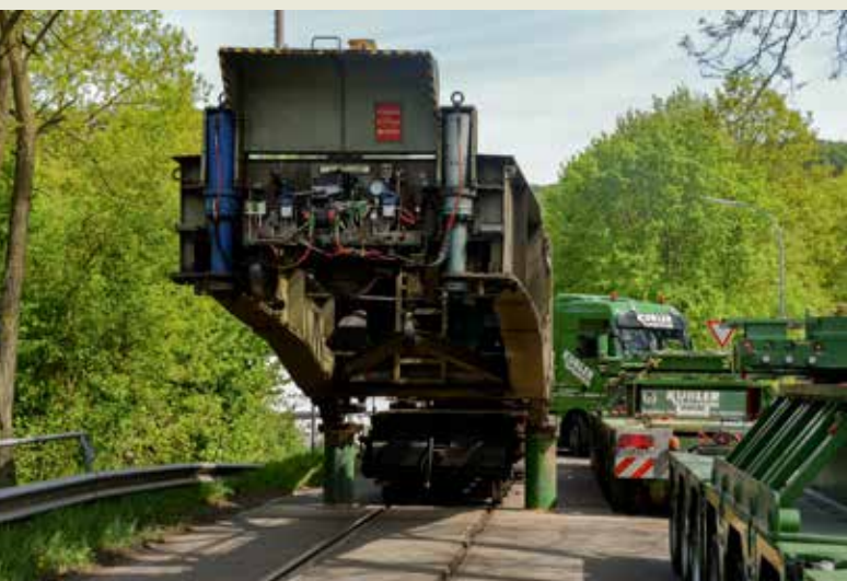
Umsetzen des Trafos auf die Schiene.
