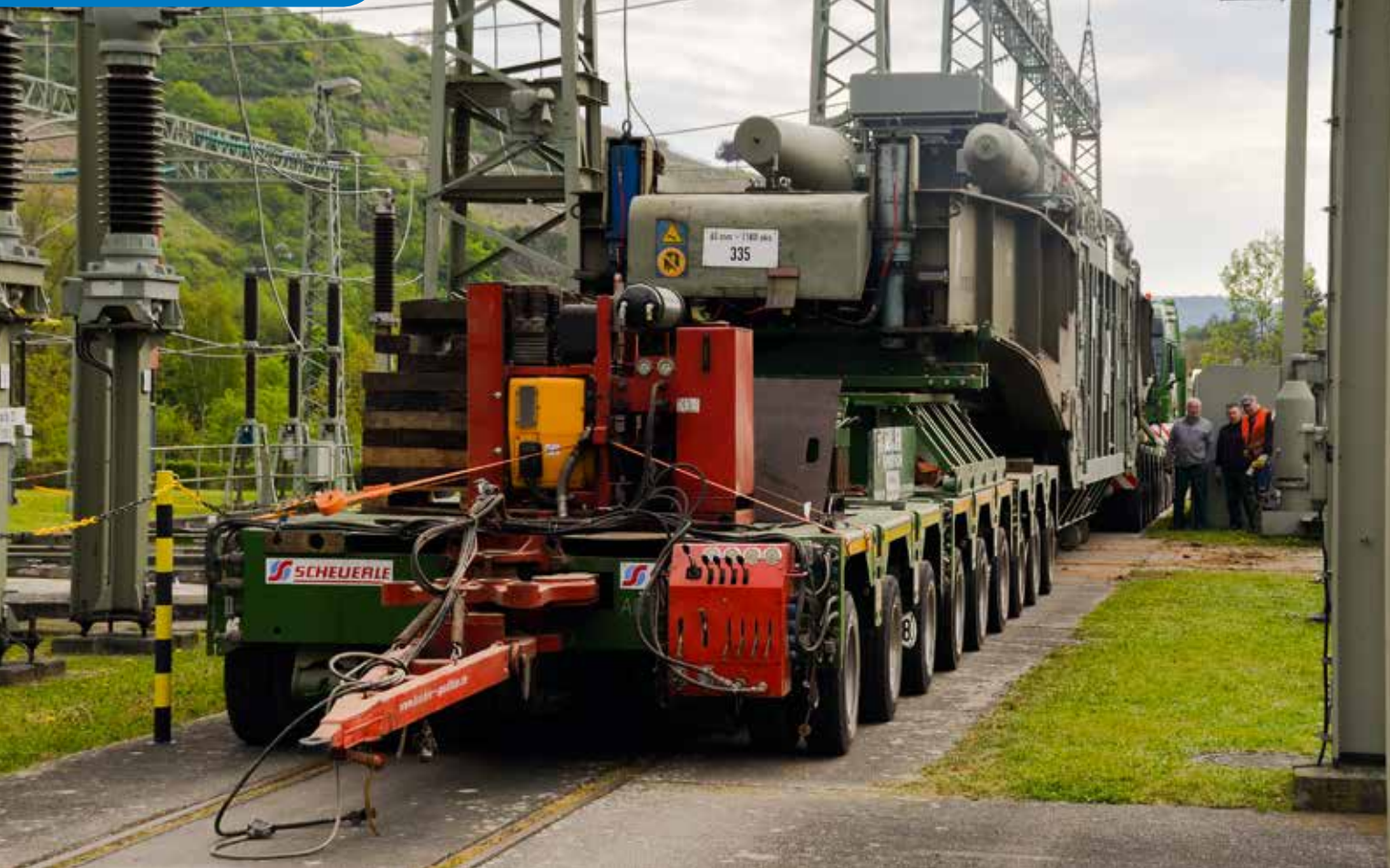
Die Verladung im Umspannwerk ist nahezu abgeschlossen.
