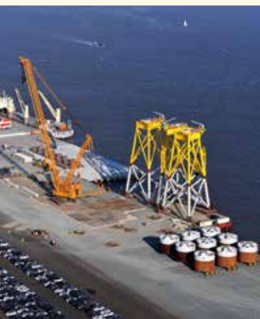
50 m hoch und 950 t schwer: neuartige Fundamente für Offshore-Windkraftanlagen.
