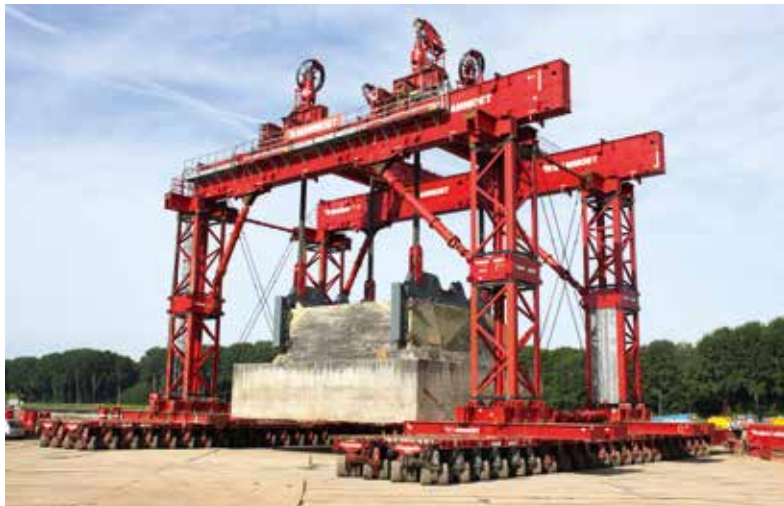
Gigant auf Reisen: Auf 88 Achslinien Scheuerle SPMT bewegt sich der 1.200 t schwere Bunker zum Zielort.
