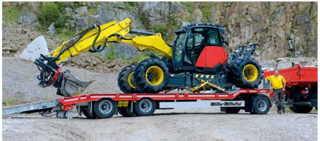
Felix Finkbeiner transportiert seinen Schreitbagger auf einem T3 Tieflader von Müller Mittelalt. Er hat sich mit seinem Schreitbagger auf anspruchsvolle Sondereinsätze spezialisiert.
