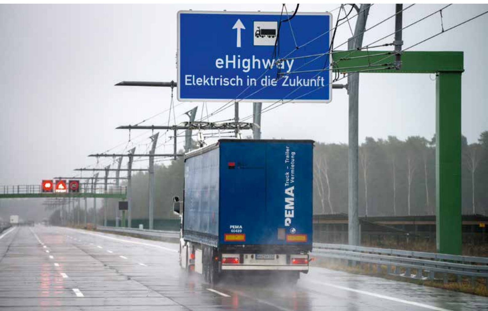
Scania G 360 4x2 mit Stromabnehmer auf dem Siemens eHighway.
