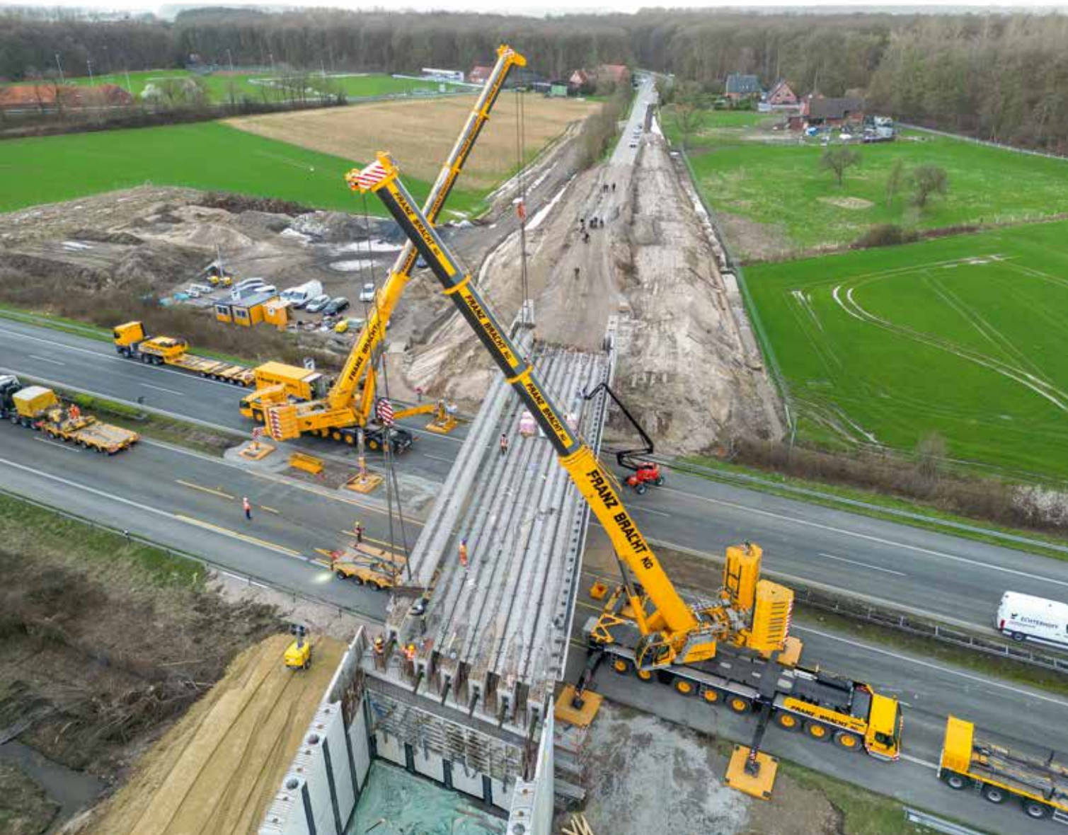
An dicken Stahlseilen schwebten die 109 Tonnen schweren Brückenträger.
