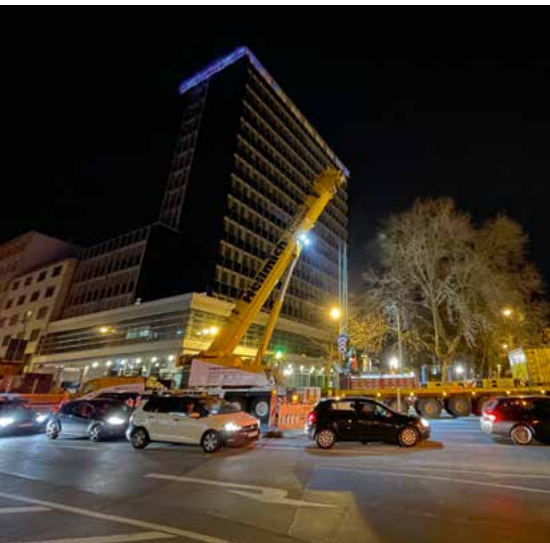
Aufgerüstet bei laufendem Verkehr.
