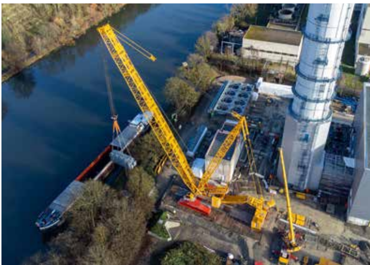
Beim Ersteininsatz hob der neue LR 1700-1.0 von Wiesbauer in Marbach am Neckar einen 230 Tonnen schweren Transformator aus einem Schiff.
