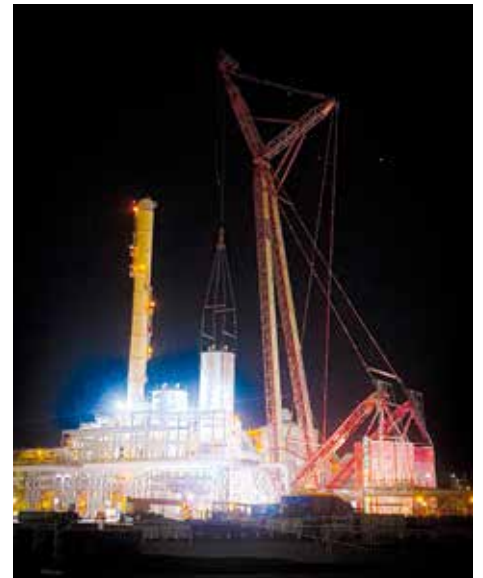
Mammoet bei der Montage eines Prozessturms in einer der weltgrößten Düngemittelfabriken in Saudi Arabien.
