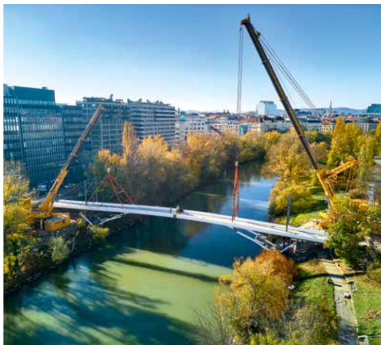
Vor dem Verschweißen beider Brückenhälften.
