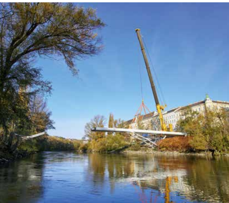
Eine Hälfte der neuen Stahlbrücke am Haken von Prangl.
