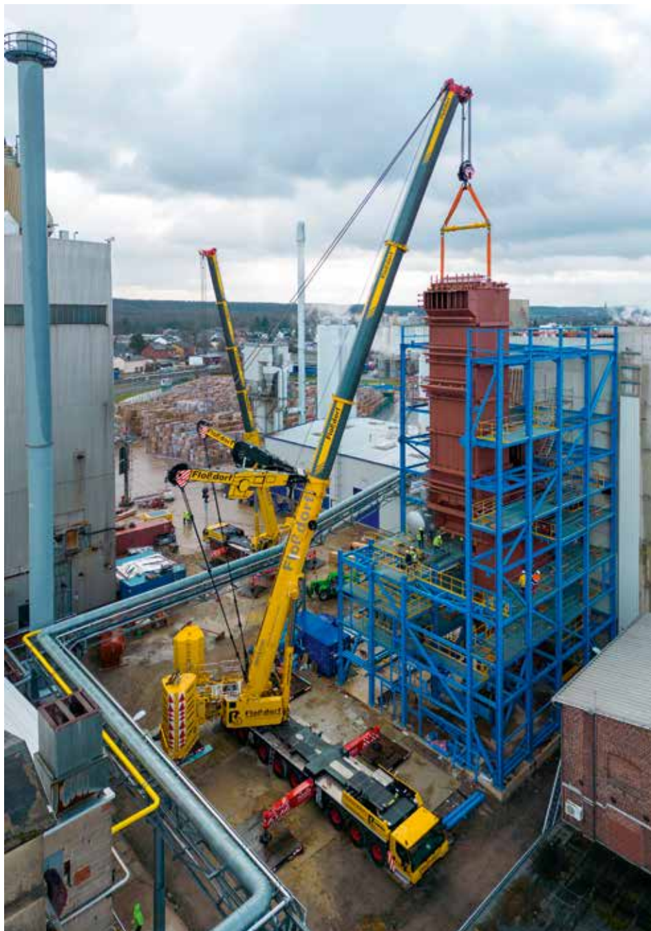
Der schwere Dampfkessel wird mit wenig Luft zwischen Last und Stahlbau eingebracht.
