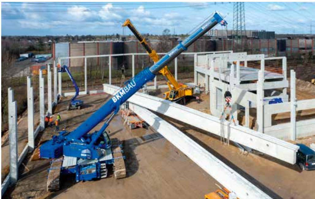
Zusammen mit einem Mobilkran LTM 1130-5.1 wird ein 40 Tonnen schwerer Deckenbinder eingebaut.
