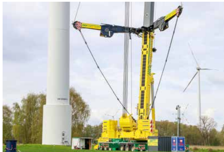
Eingesetzt war der Kran in T3YV2EN Konfiguration: 45 m Hauptmast, 12 m Teilverlängerung, 49 m Wippe und 105 t Ballast im Radius 8,4 m.
