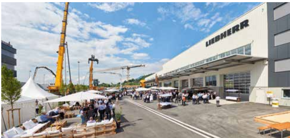
Auf dem über 30.000 m 2 großen Gelände sind Verwaltungs-, Reparatur- und Werkstattbereich gebündelt.
