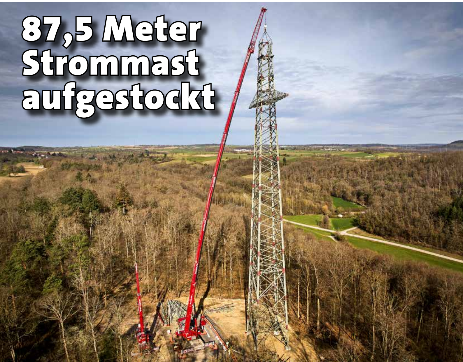
Der AC 6.300-1 mit 80 Meter Hauptmast und 21 Meter Doppelklappspitze im Einsatz.
