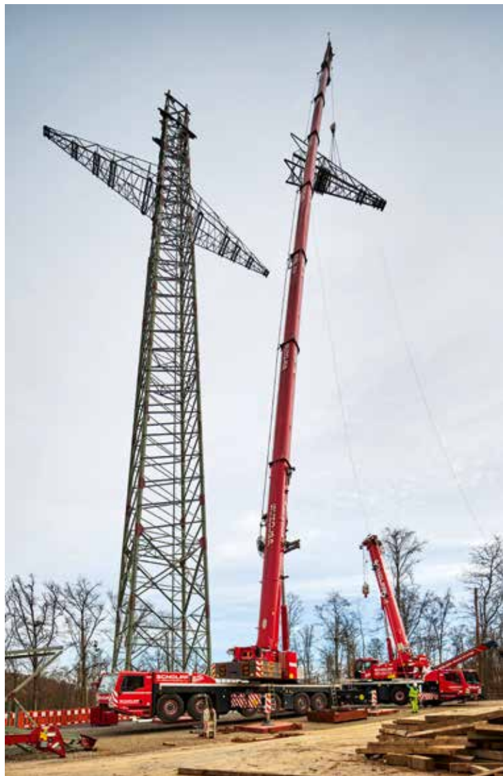
Einheben der Strommastspitze.
