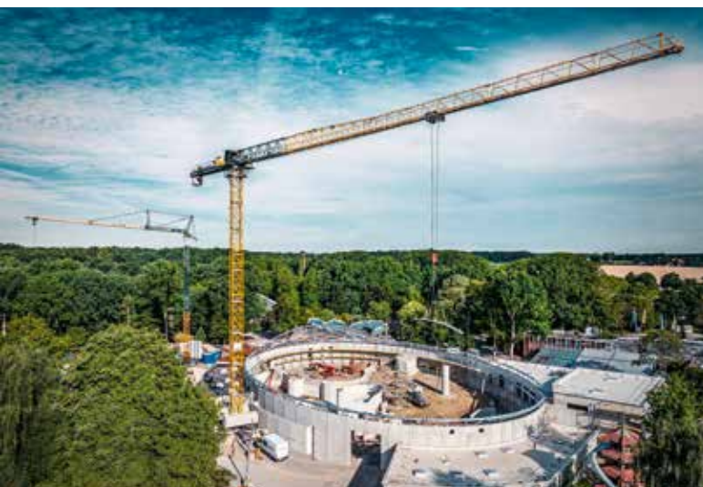
Ein 172 EC-B 8 von Liebherr baute an der neuen Tropenhalle im Allwetterzoo in Münster mit.
