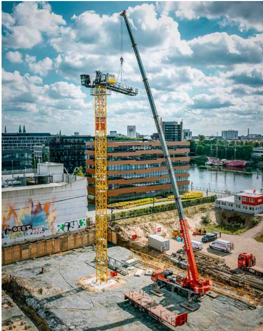
In Bremen wurde der 172 EC-B 8 für den Bau eines Bürogebäudes mit Unterstützung eines LTM 1120 montiert.
