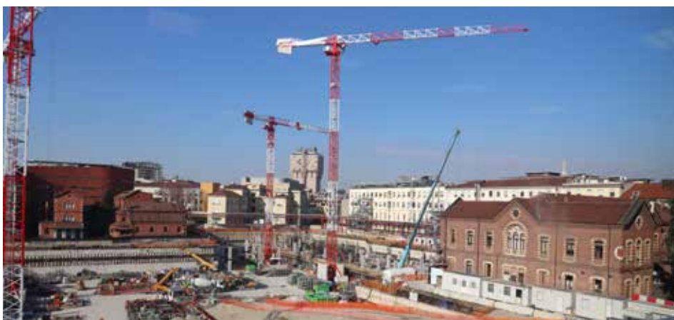
Blick auf die 23.000 m 2 große Baustelle des Policlinico di Milano.
