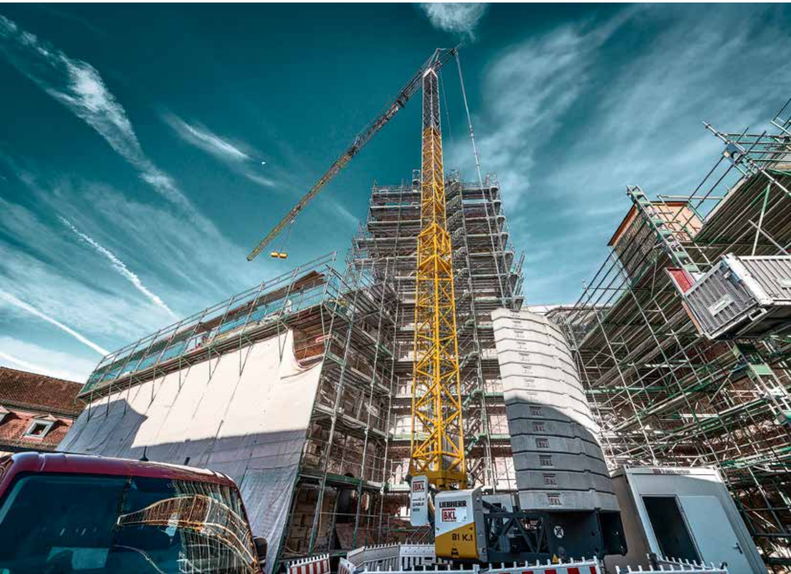
Dank des geringen Drehkreisradius konnte der 81 K.1 direkt am Gebäude positioniert werden.
