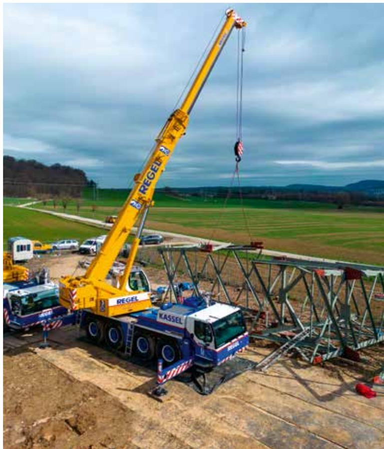
Während der große Liebherr-Mobilkran die Gittermast-Konstruktion der Überlandleitung in die Höhe treibt, bereitet der LTM 1070-4.2 das nächste Bauteil zur Montage vor.
