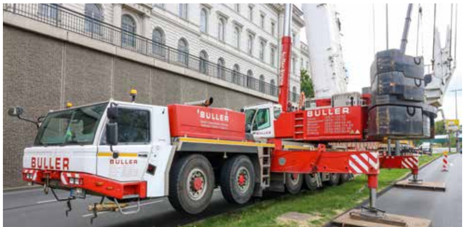
Der Tadano ATF 400G-6 ist bereit für den ersten Hub.
