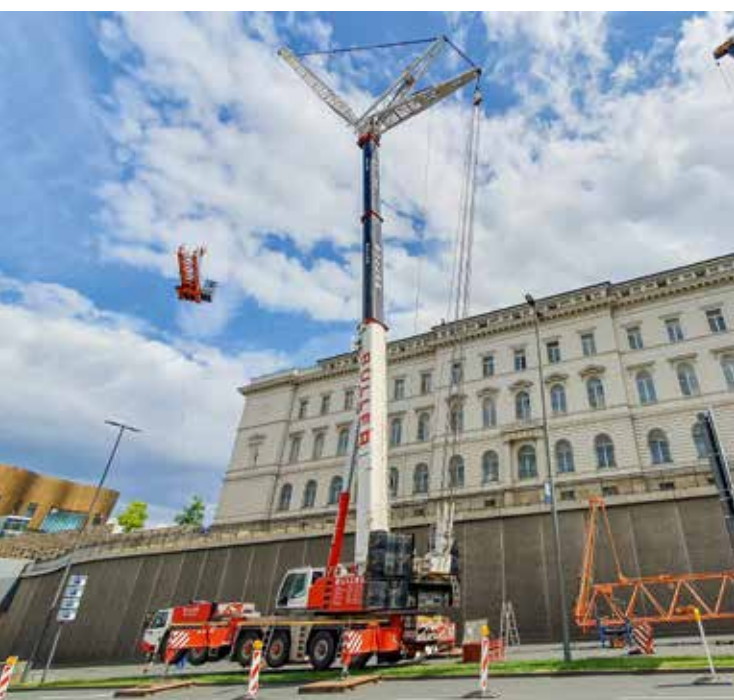
Ein weiteres Teilstück wird eingehoben.
