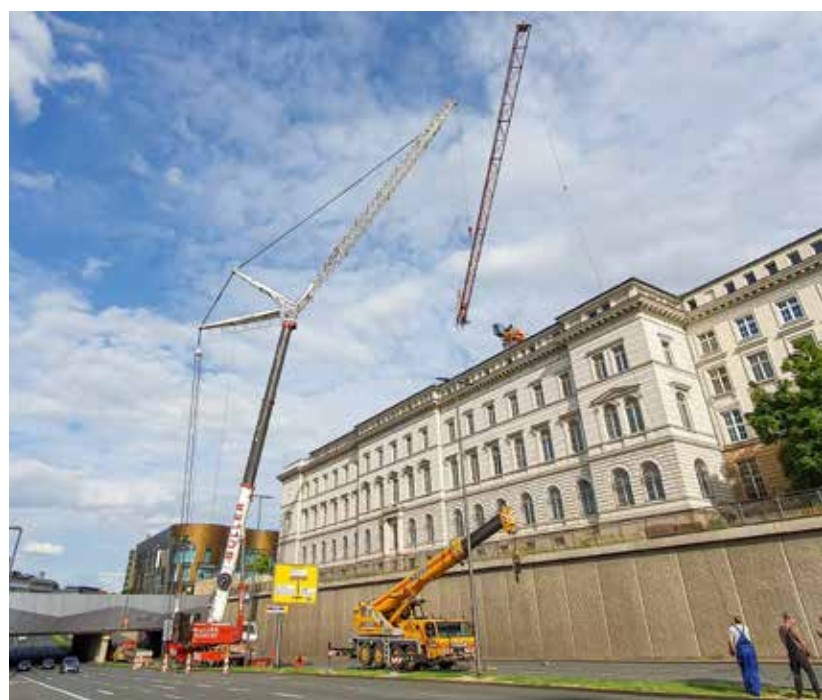
Der in einem Stück vormontierte Hauptausleger schwebt ein.
