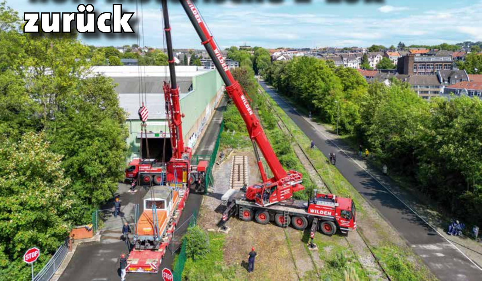
Per Tandemhub von einem LTM 1130-5.1 und LTM 1070-4.1 der Wilden Kranvermietung wird die alte E-Lok auf ein Gleisstück an der Wuppertaler Nordbahnstraße gehoben.
