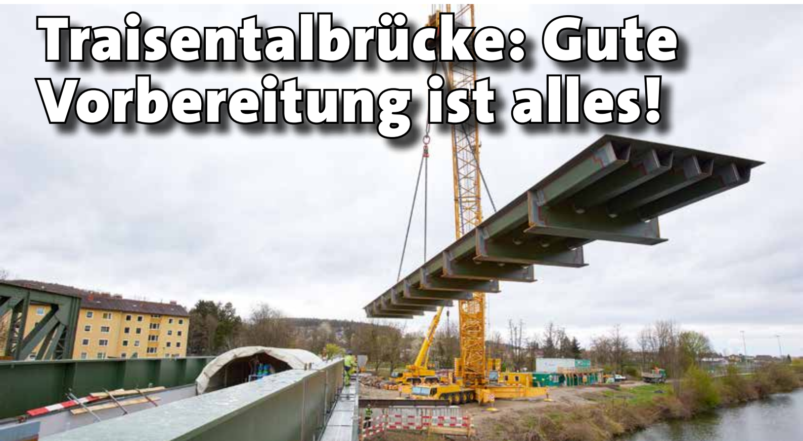
Der Terex Demag TC 2800-1 Gittermastkran von Prangl hebt die Teile der neuen Brücke über der Traisen.
