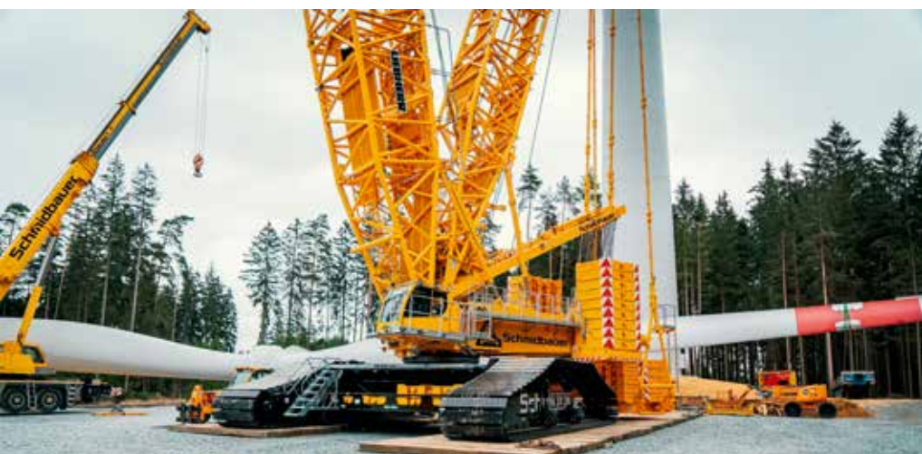
Die Liebherr-Raupe LR 1800 von Schmidbauer beim Einsatz in Münchberg/Jehsen.
