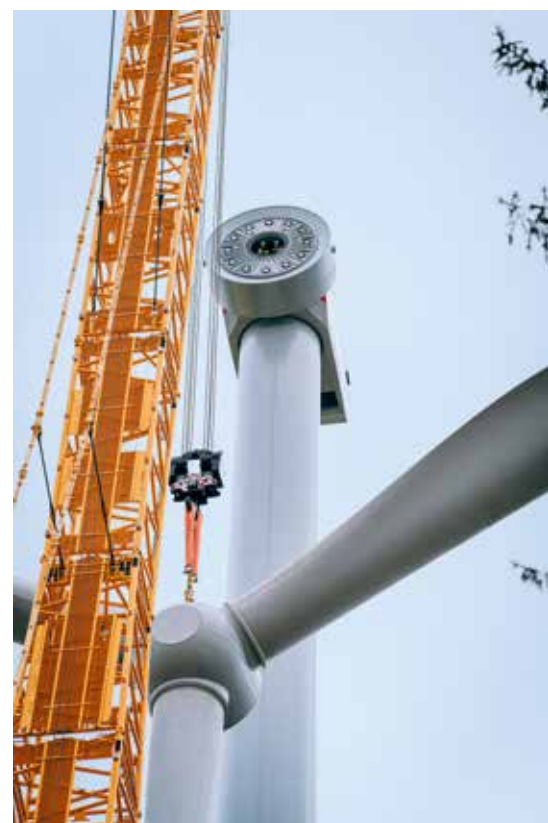
Kurz vor der finalen Montage, WKA-Rotorblätter-einhub von der LR 1800.
