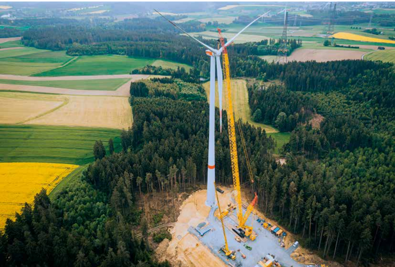
Die Liebherr-Raupe LR 1800 von Schmidbauer beim Einhub der WKA-Flügel in Münchberg.
