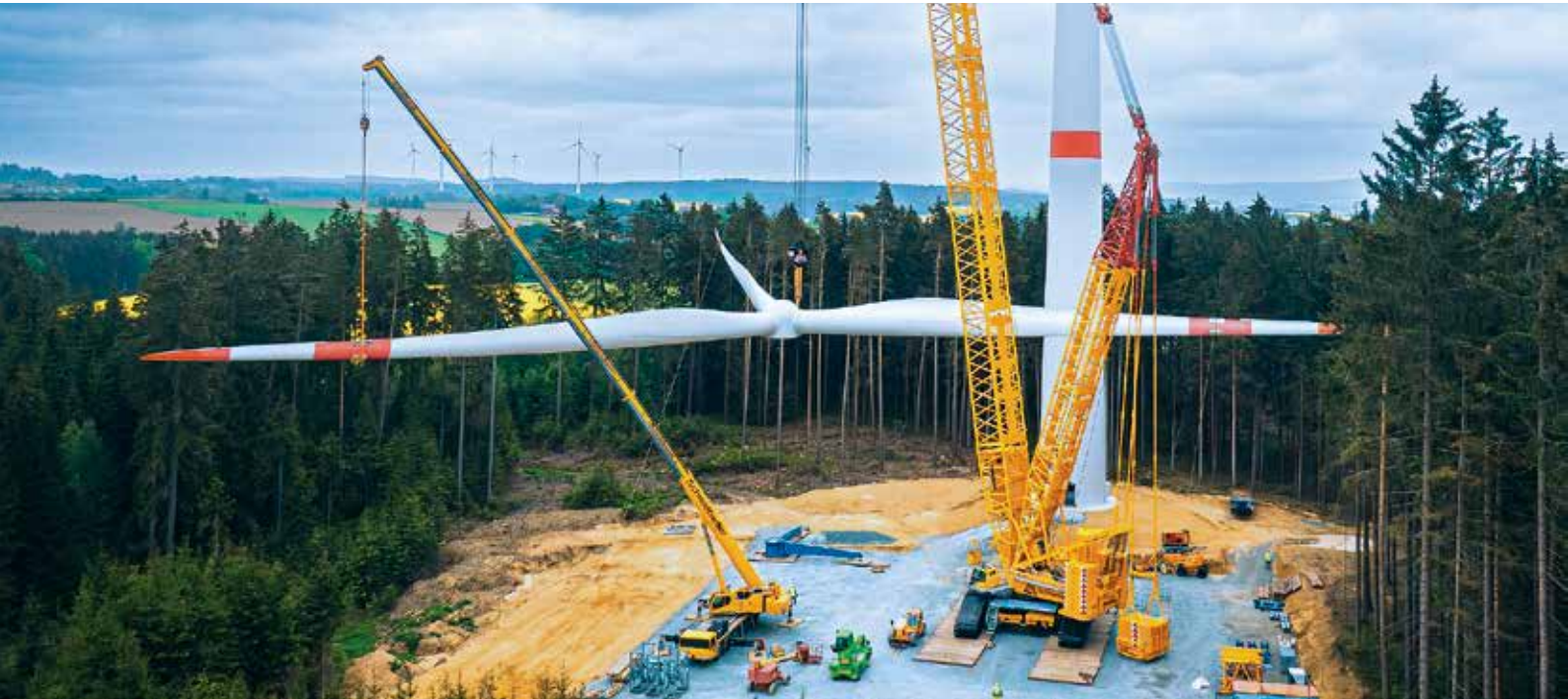
Die Liebherr-Raupe LR 1800 von Schmidbauer beim Einhub der WKA-Flügel in Münchberg.
