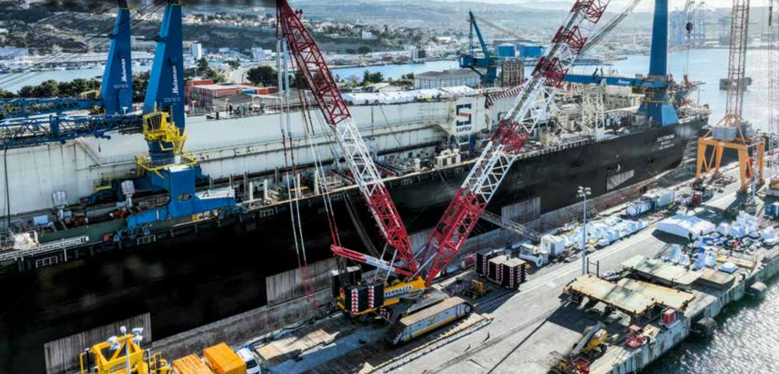
Die Tadano-Raupe CC 68.1250-1 von Vernazza im Einsatz am Hafen von Marseille.
