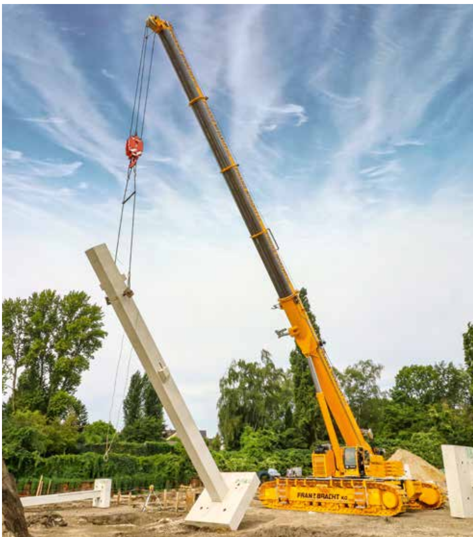
Der neue GTC-2000 von Bracht bei seinem ersten Baustellen-Einsatz in Mülheim-Ruhr.
