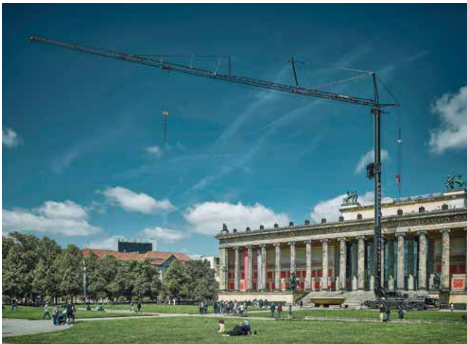
In Berlin und Brandenburg im Einsatz: Der Fünfachser MK 140 von Fröhlich Bau Kran und Baustellenlogistik.
