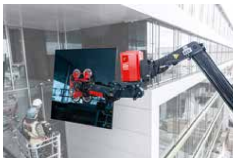
Überkopfmontagen oder Schrägen mit Fingerspitzengefühl und Präzision: Kein Problem für den eT-Litocran700.
