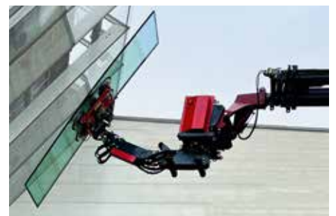
Überkopfmontagen oder Schrägen mit Fingerspitzengefühl und Präzision: Kein Problem für den eT-Litocran700.
