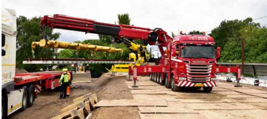
Einhub der Elemente per Tandemhub.
