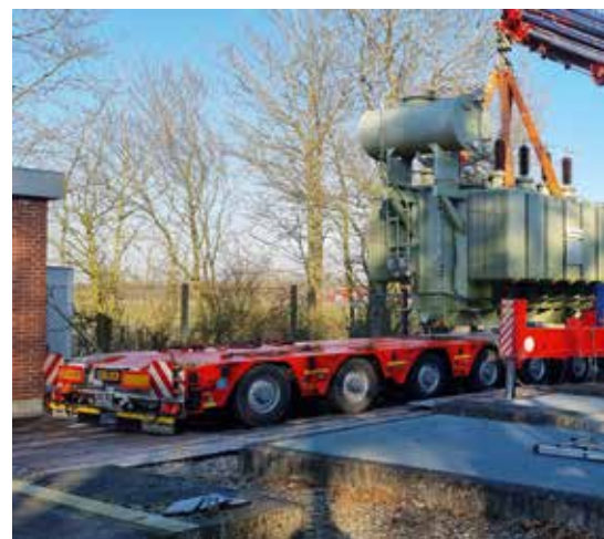
Einhub eines 53-Tonnen-Trafos in 47 Minuten.
