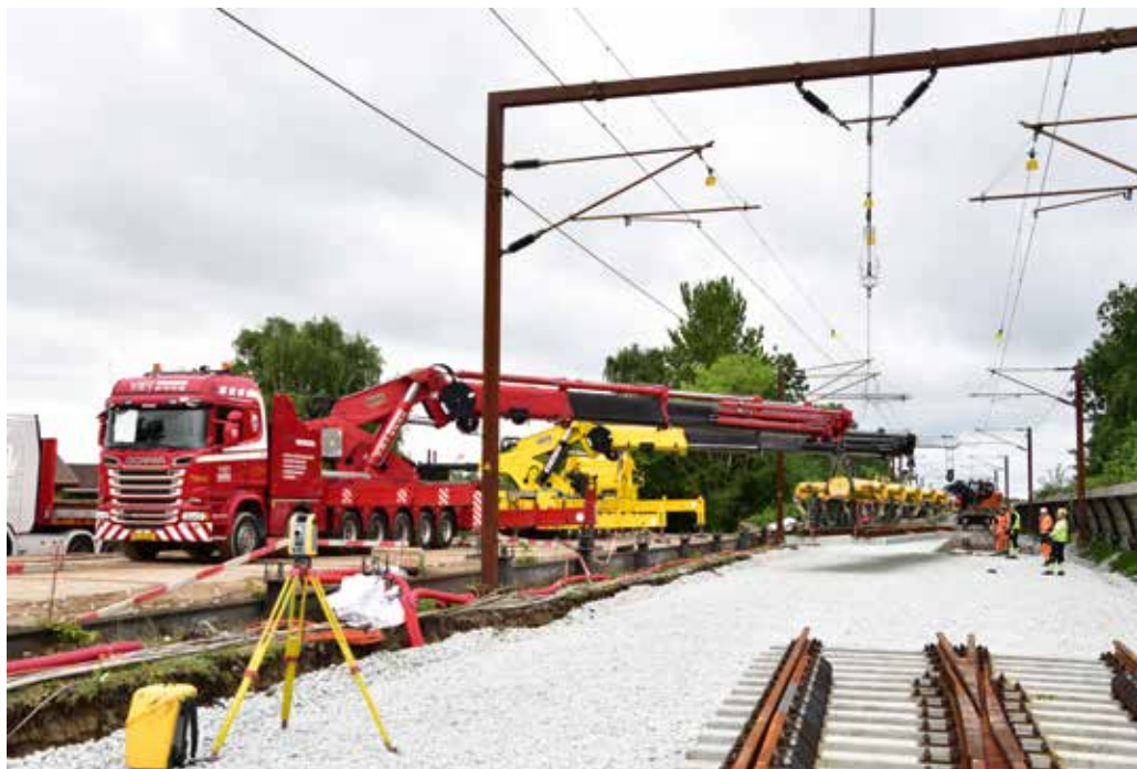
Genaueres Einmessen nach dem Einhub des ersten Gleiselementes.
