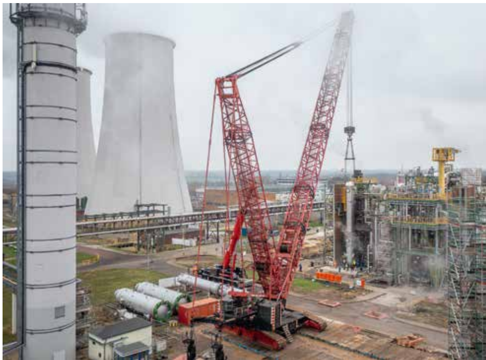
Heben des Subreaktors in die Einbauposition.
