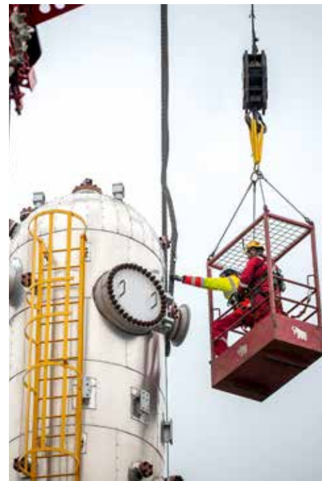
Installation des Schwerlast-Rigging am Subreaktor.
