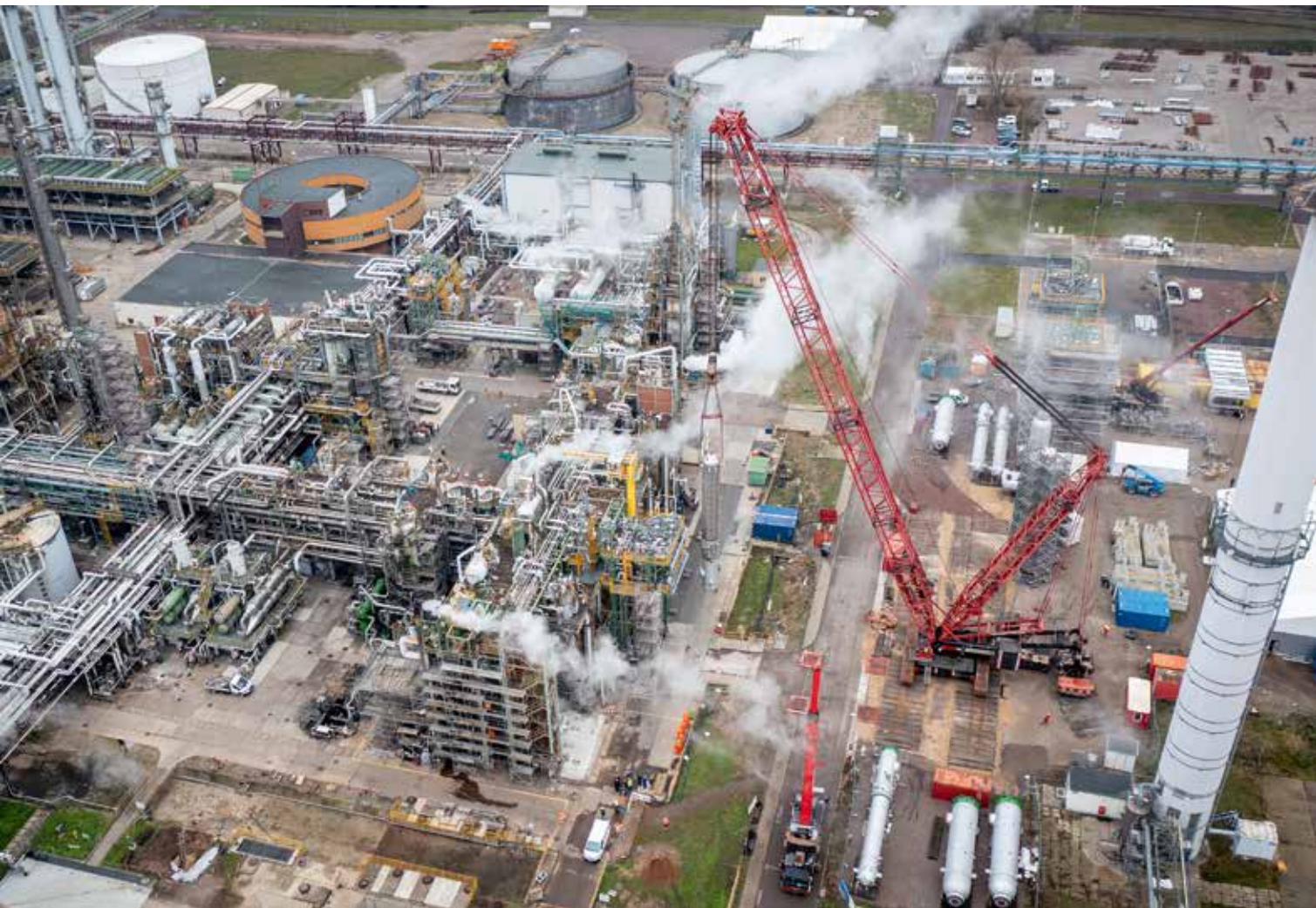
Schwenken des Subreaktors in Richtung der Anlage.
