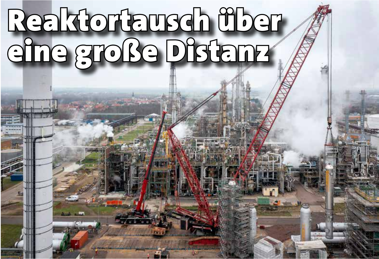
Anheben des Subreaktors auf der Vormontagefläche.
