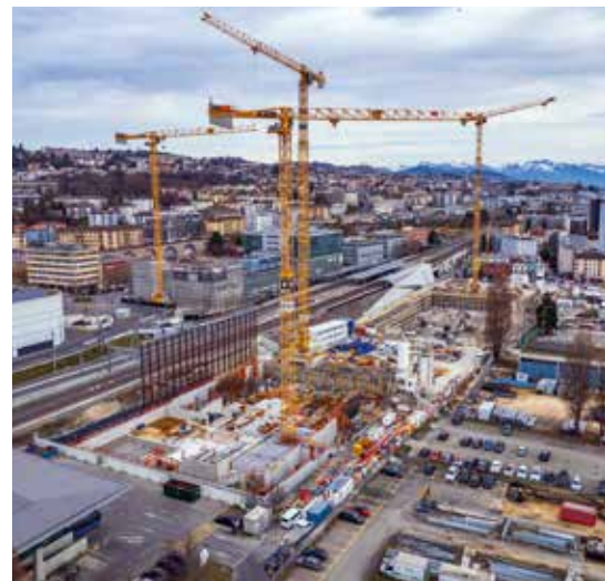
Zwei der Türme mussten in der Nähe der SBB-Strecke positioniert werden.
