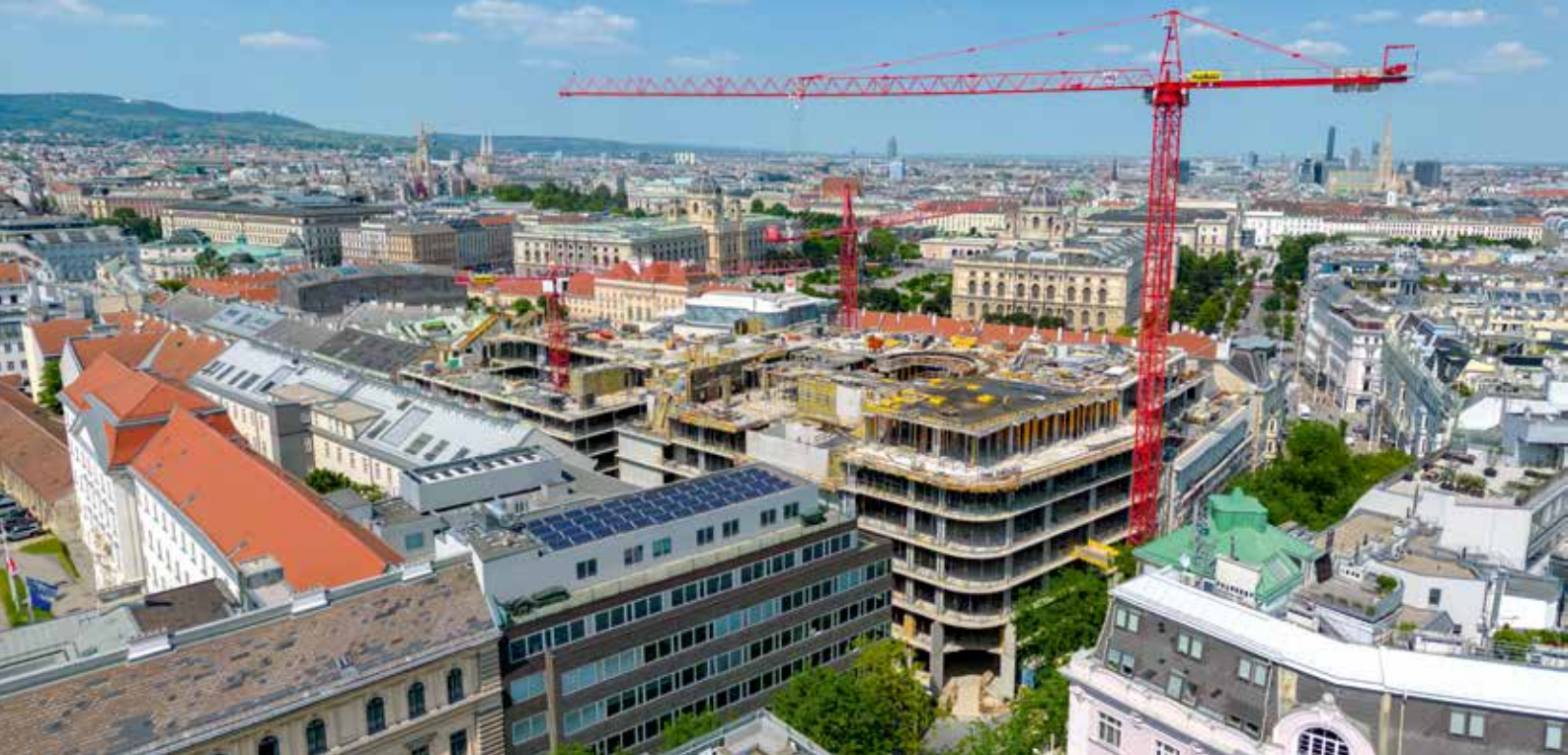
Turmdrehkrane von Wolff im Einsatz von Habau in Wien.
