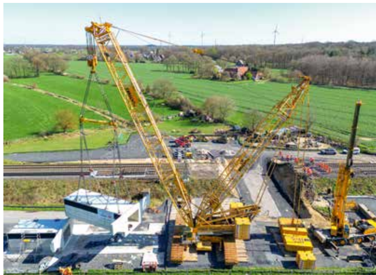
Einhebung einer Fußgänger-/Radunterführung an der Bahnstrecke in Sonsfeld (NRW, Nahe Haldern) mit 30 m Derrickauleger, 36 m Hauptausleger, 160 t Oberwagenballast und 300 t Schwebeballast. Die Last betrug ca. 350 t bei einer Ausladung von ca. 21 m.
