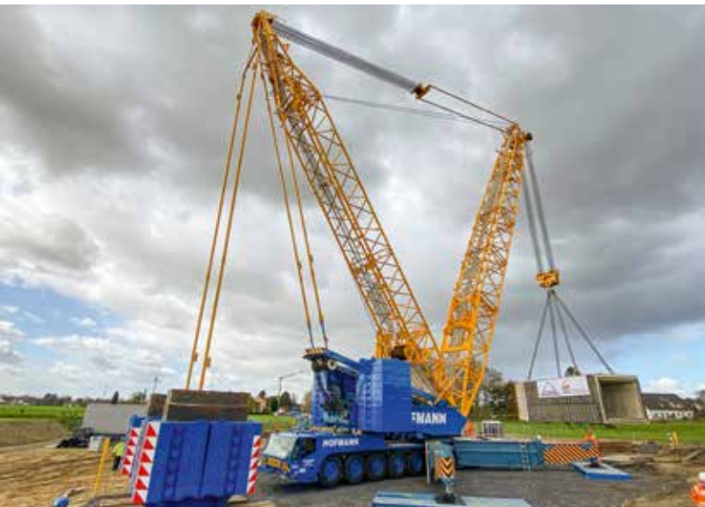
Einhub einer PKW-Unterführung in Voerde.
