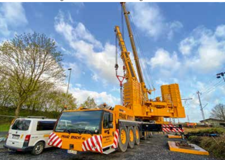
Franz Bracht – Einsatz mit Liebherr LTM 1650-8.1 und Tadano AC 700 am 11. April 2023.
