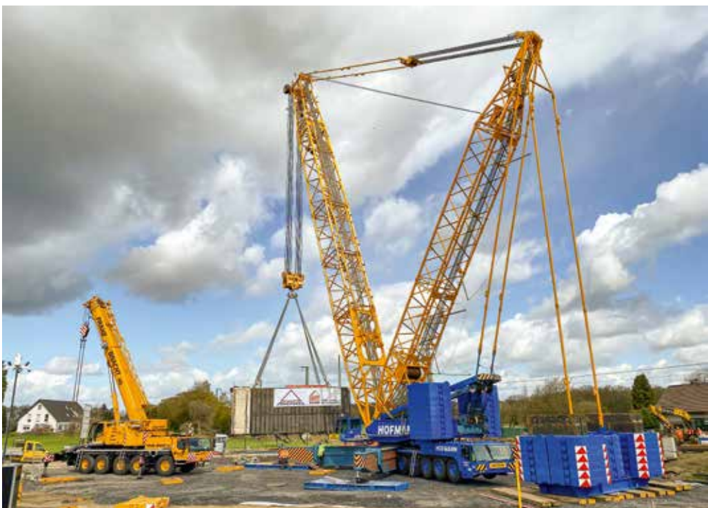
Hofmann – Einsatz mit Demag TC 2800-1 am 11. April 2023.
