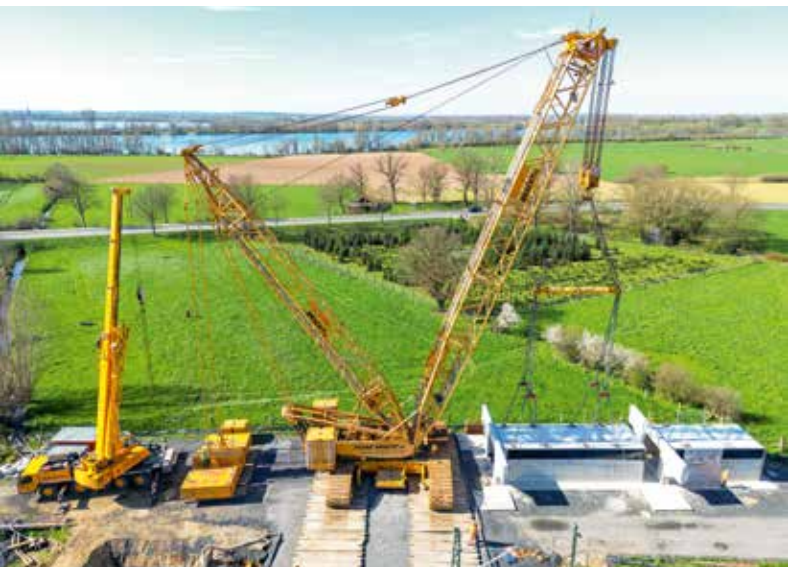
Franz Bracht – Einsatz mit Demag CC 2800-1 am 04. April 2023.
