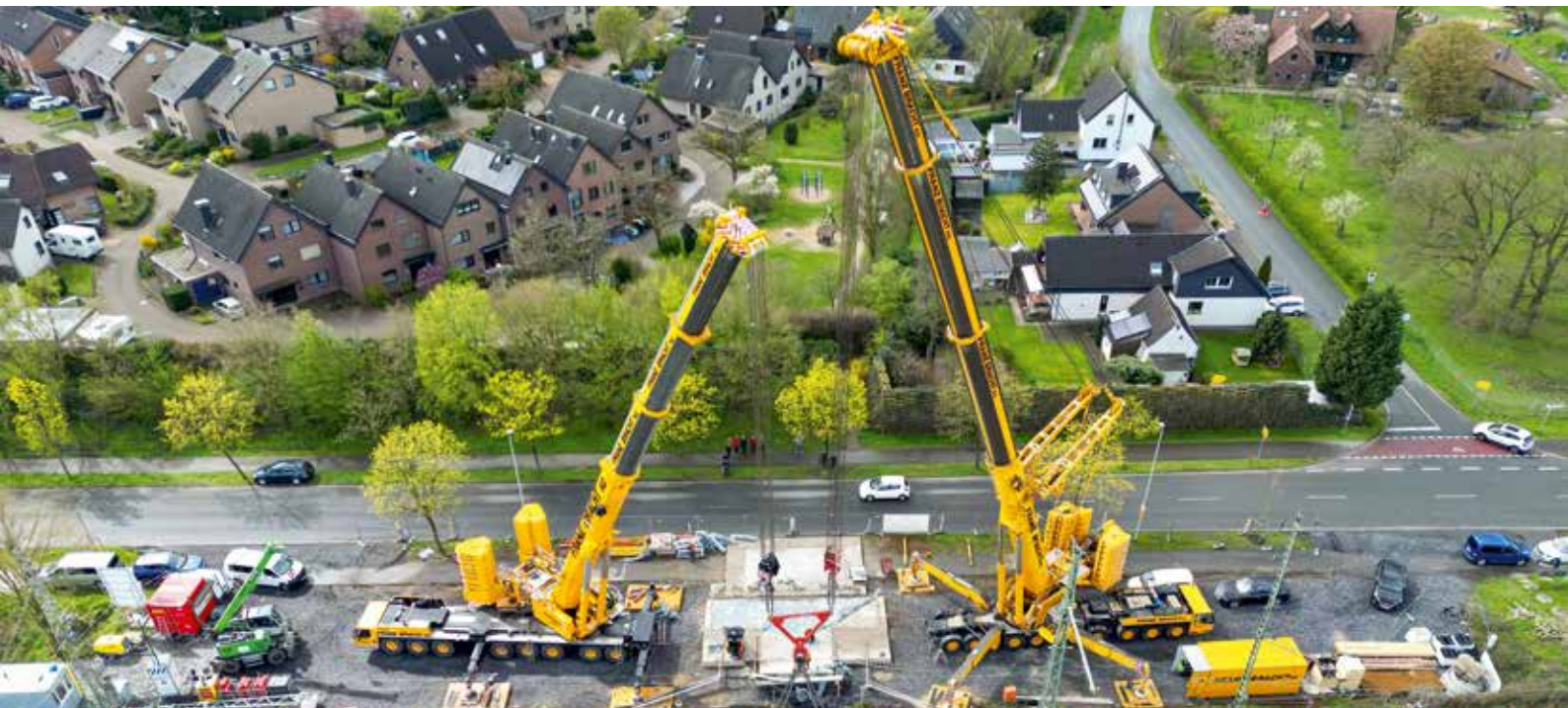
LTM 1650-8.1: Hauptmast: 33,8 m, Ballast 155 t bei 8,4m Radius Ausladung ca. 16 m mit ca. 110 t Last – AC 700 mit SSL, Hauptmast: 40,5 m, Ballast 160 t, Ausladung ca. 10 m auch mit ca. 110 t Last.
