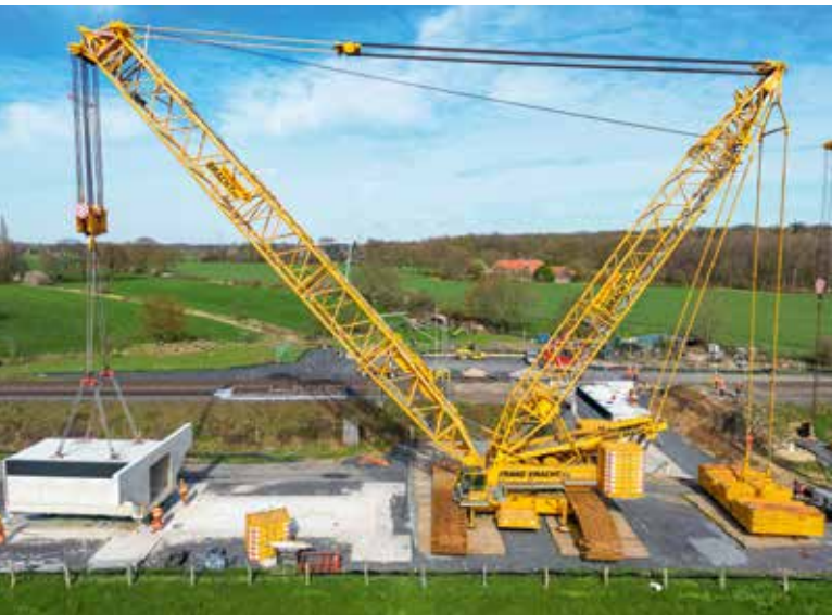
... mit 30 m Derrickauser, 36 m Hauptausleger, 160 t Drehbühnenballast und 250 t Schwebeballast. Die Last betrug ca. 250 t bei einer Ausladung von ca. 22 m.
