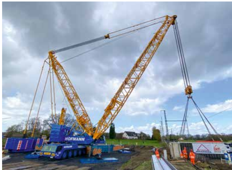
Demag TC 2800-1 mit Derrickauleger, 42 m Hauptausleger, 160 t Oberwagenballast, 280 t Schwebeballast. Die Last betrug ca. 260 t bei einer Ausladung von ca. 26 m.
