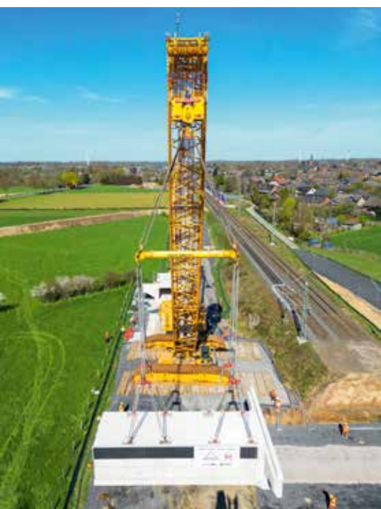
Einhebung einer Unterführung für den Bach Brahmelsgraben in Sonsfeld...
