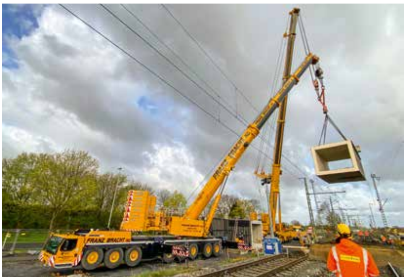
Einhub (Teil 1) einer Fußgänger-/Radfahrerunterführung mit SSL in Voerde.
