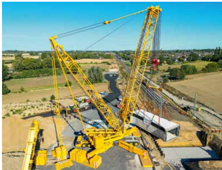
Einhebung einer Fußgänger-/Radunterführung an der Bahnstrecke in Sonsfeld (NRW, Nahe Haldern) mit 30 m Derrickauleger, 36 m Hauptausleger, 160 t Oberwagenballast und 300 t Schwebeballast. Die Last betrug ca. 350 t bei einer Ausladung von ca. 21 m.
