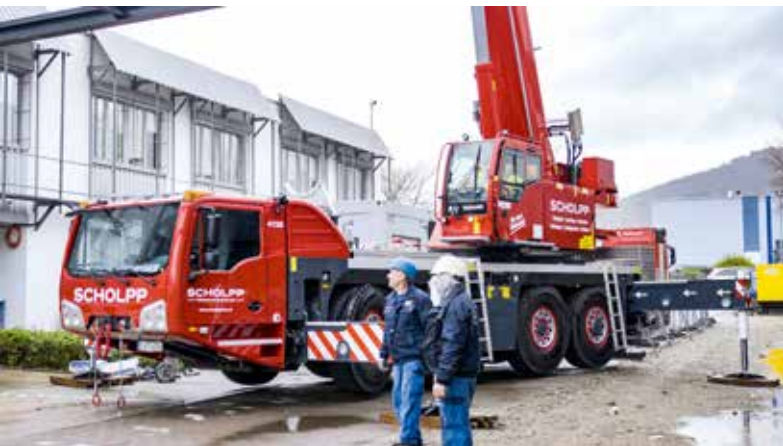
Enge Baustellenverhältnisse beim Einsatz in Bad Rotenfels.
