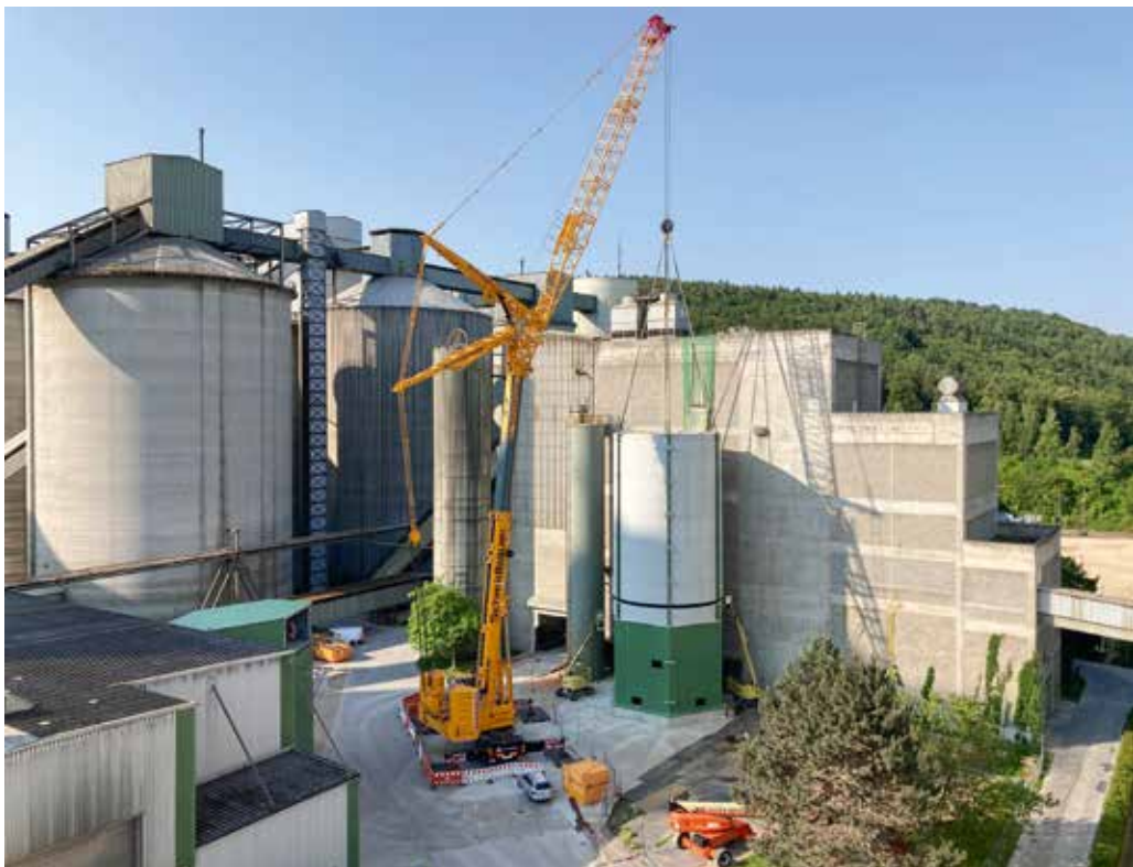
Der Liebherr-Mobilkran LTM 1650-8.1 montiert das neue Silo für Zuschlagstoffe zur Zementherstellung.
