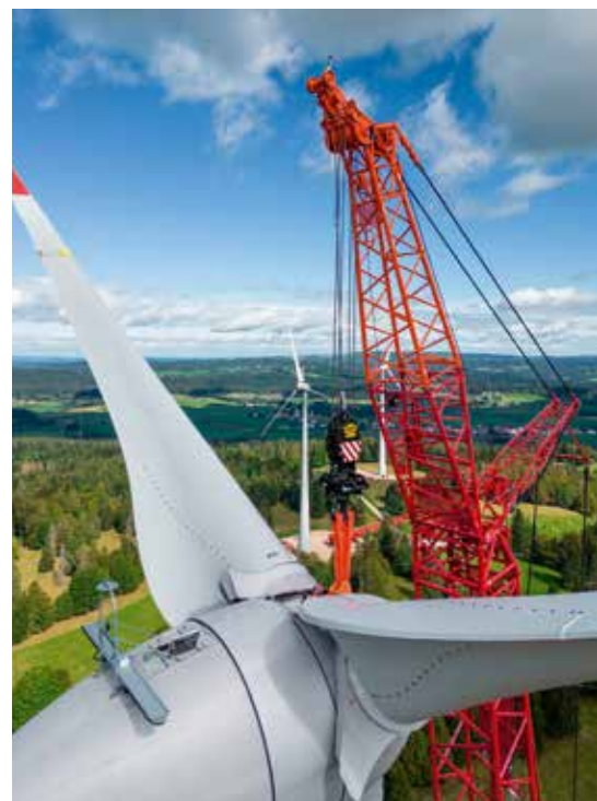
Dieser am Boden montierte Rotorstern mit seinen 40 Meter langen Blättern wird hier beim Anheben in Vertikallage geschwenkt. Die beiden seitlichen Abstützungen links am Raupenträger des LR 11000 ermöglichen das Aufrichten des Gittermasts ohne Verwendung von Derrick-Ausleger und Derrick-Ballast.
