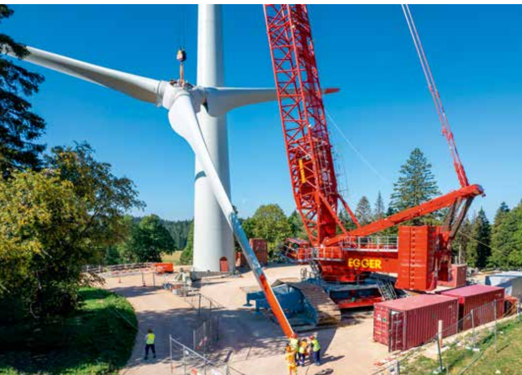
Dieser am Boden montierte Rotorstern mit seinen 40 Meter langen Blättern wird hier beim Anheben in Vertikallage geschwenkt. Die beiden seitlichen Abstützungen links am Raupenträger des LR 11000 ermöglichen das Aufrichten des Gittermasts ohne Verwendung von Derrick-Ausleger und Derrick-Ballast.
